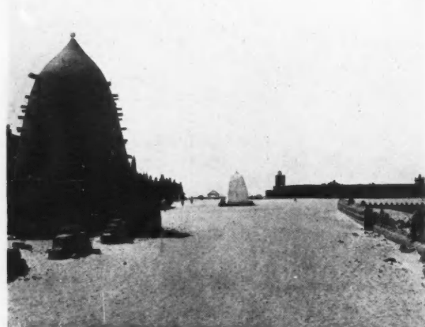
TIMIMOUN. Grand Place. Au premier plan, puits municipal se profilant sur l'hôtel transatlantique et la ville neuve ; au fond, le bordj militaire. Le vieux ksar se trouve à droite, au-delà de l'enceinte ruinée du premier plan.
