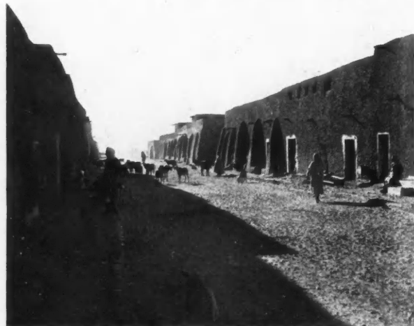
TIMIMOUN. Rue de la ville nouvelle. Noter l'importance des contreforts indispensables pour des murs en argile friable.
