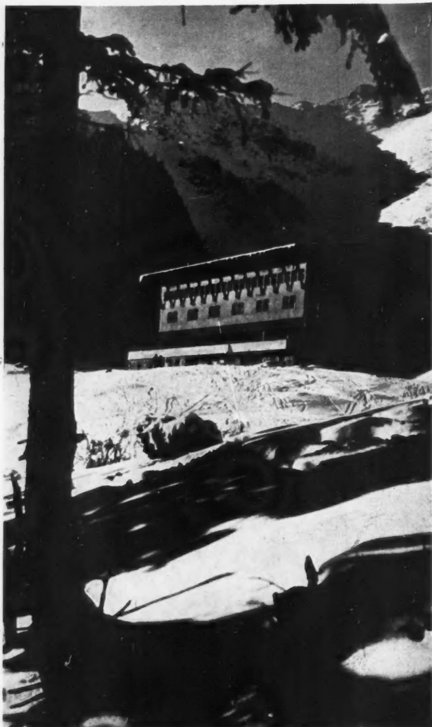
Restaurant pour 200 personnes ; 40 chambres en 3 étages ; ossature en béton armé ; Murs en voiles de béton armé revêtus de granit de 20 cm. Plaques isolantes à l'intérieur ; charpente en bois.
