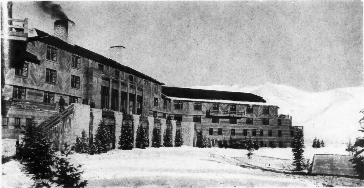
SUN VALLEY LODGE. FAÇADE COTÉ DE L'ENTRÉE PRINCIPALE
