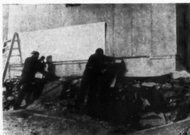
POSE DU REVÊTEMENT EXTÉRIEUR EN ALUMINIUM
