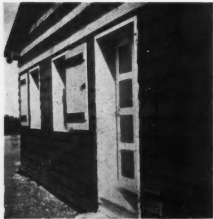
REVÊTEMENTS ÉCONOMIQUES EN BOIS. A GAUCHE : PLANCHES DE SAPIN POSÉES A RECouvreMENT SUR PAPIER BITUMÉ, A DROITE : REVÊTEMENT EN «ÉCOINS» POSÉS SUR BARDAGE SAPIN. COUVERTURE EN TUILES DE MÊLÈZE
