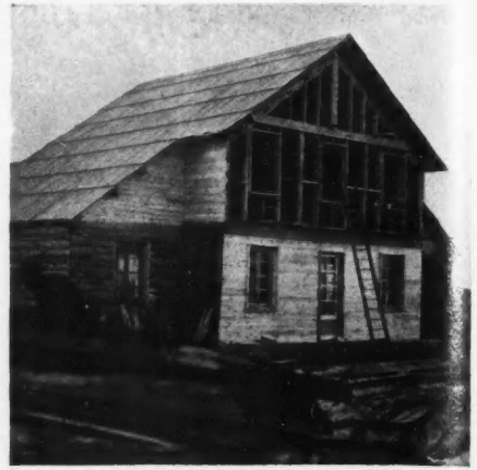
REVÊTEMENTS ÉCONOMIQUES EN BOIS. A GAUCHE : PLANCHES DE SAPIN POSÉES A RECouvreMENT SUR PAPIER BITUMÉ, A DROITE : REVÊTEMENT EN «ÉCOINS» POSÉS SUR BARDAGE SAPIN. COUVERTURE EN TUILES DE MÊLÈZE
