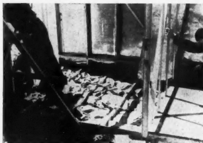
LESTAGE D'UN CAISSON
