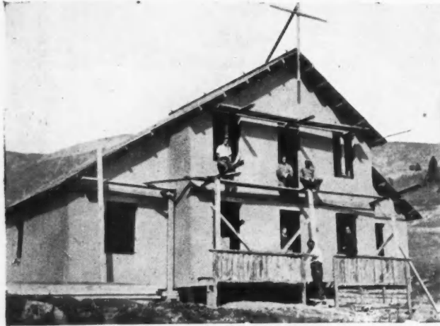
LA FOUX D'ALLUS. Bâtiment N° 1 (en cours de construction, avec son revêtement en ISOREL, double paroi, « isolant » à l'intérieur, « mi-dur » à l'extérieur).
