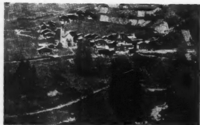
IV-74 VUE AVANT L'INCENDIE
