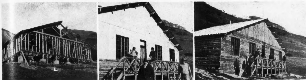
TROIS PHASES DE CONSTRUCTIONS D'UN CHALET (Voir P. 41). OSSATURE - REVÊTEMENT D'ISOREL. REVÊTEMENT D'ECOINS
