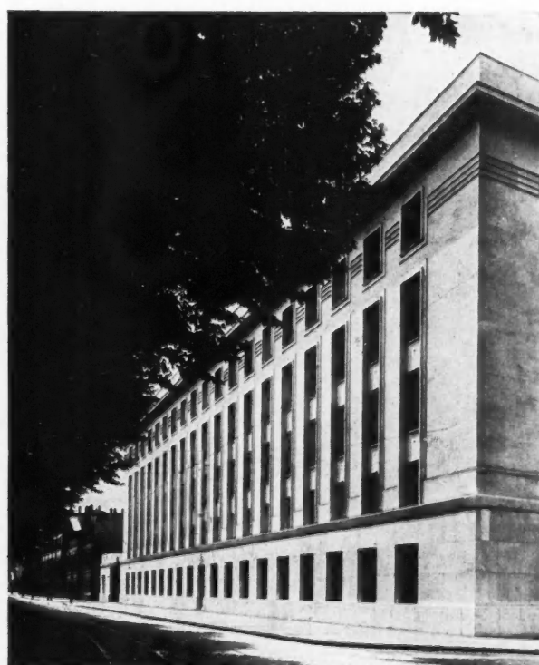
FAÇADE QUAI GAILLETON
