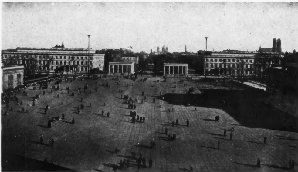
MUNICH - LA KOENIGSPLATZ - A GAUCHE LA MAISON DU FUHRER - A DROITE, LA MAISON DU PARTI - AU MILIEU, LES DEUX TEMPLES DU SOUVENIR
