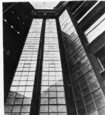
UN ESCALIER SUR COUR Doc. Douille
