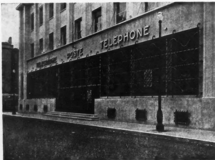
V-76 FAÇADE SUD (SERVICES POSTAUX)
