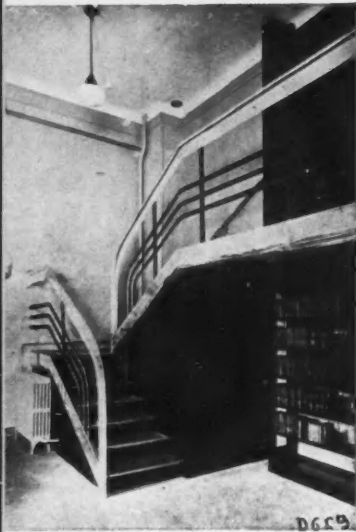
Bibliothèque, 6, rue Fessard 19 me Arrond. Escalier d'accès au balcon
