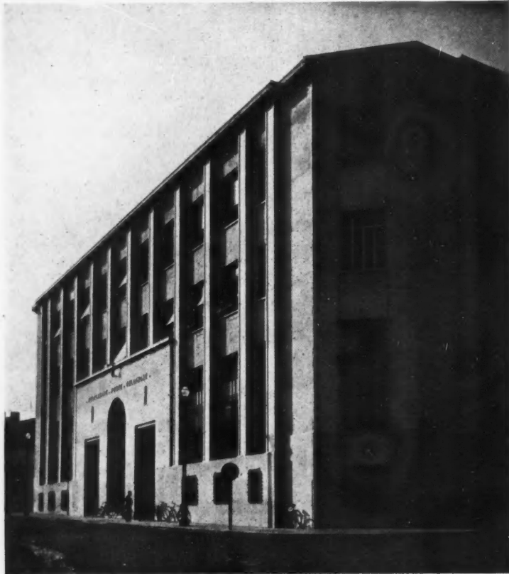
FAÇADE NORD (ENTRÉE DU PUBLIC)
