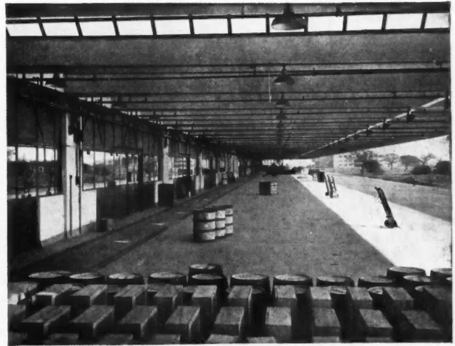
BATIMENT A REZ-DE-CHAUSSÉE. PARTIE EN PORTE A FAUX
