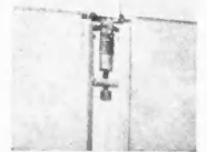
COUPE SUR UN JOINT ET VERIN DE SERRAGE AU PLAFOND
