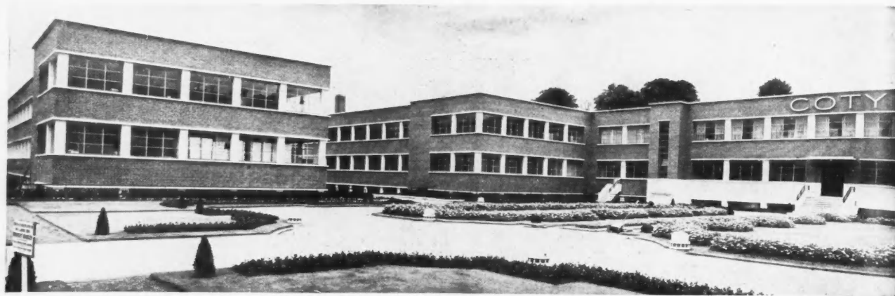
FAÇADE SUR LA COUR D'ENTRÉE
