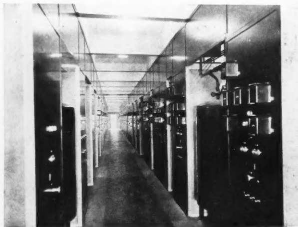
GALERIE DES TRAVAUX DE RELAIS
