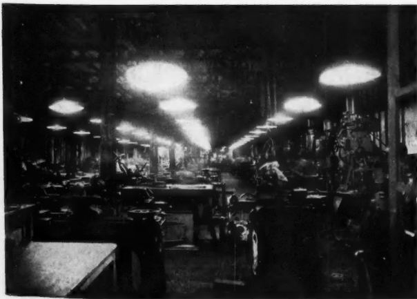
Fig. 5 et 6. ECLAIRAGE D'UN ATELIER ET D'UNE IMPRIMERIE PAR APPAREILS A REFLECTEUR DIFFUSANT DE GRANDES DIMENSIONS
