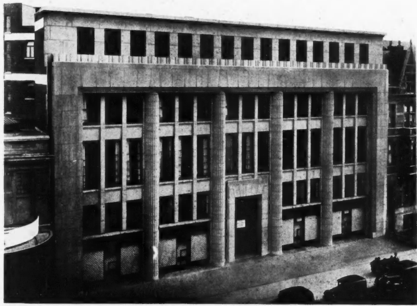
FAÇADE BOULEVARD DE LA SAUVENIÈRE
