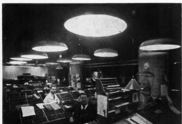
Fig. 5 et 6. ECLAIRAGE D'UN ATELIER ET D'UNE IMPRIMERIE PAR APPAREILS A REFLECTEUR DIFFUSANT DE GRANDES DIMENSIONS
