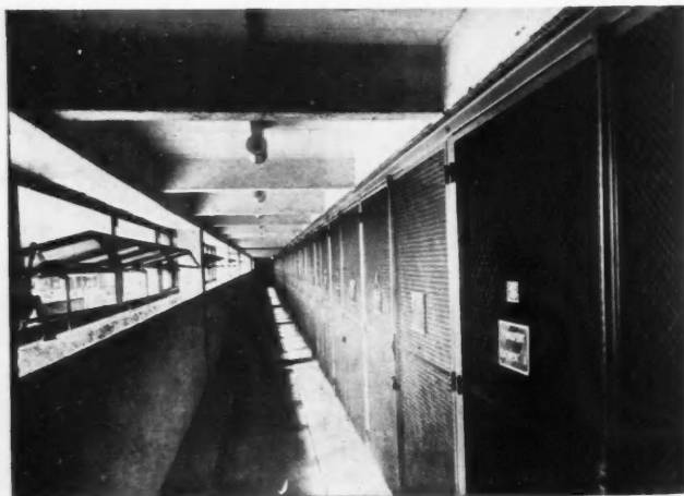
VI-50. COULOIR SUR LES CELLULES DES SELFS (CHASSIS OUVRANTS AUTOMATIQUES)
