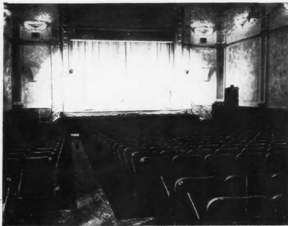
VUE DE LA SALLE. ON APERÇOIT LES DEUX BOUCHES DE SOUFFLAGE DE PART ET D'AUTRE DU RIDEAU
