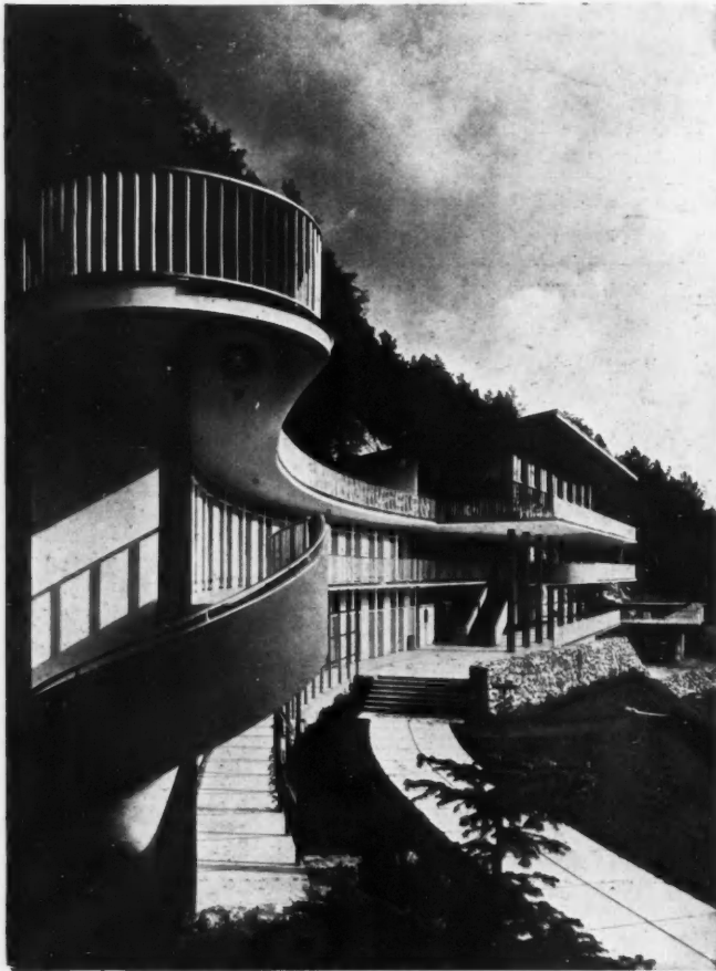
EXTRÉMITÉ DE L'AILE DES CABINES
