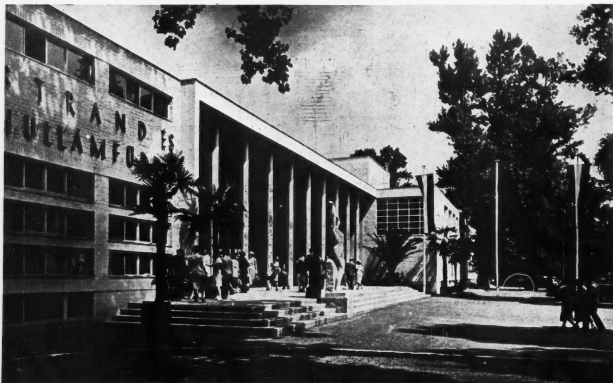
FAÇADE PRINCIPALE D'ENTRÉE
