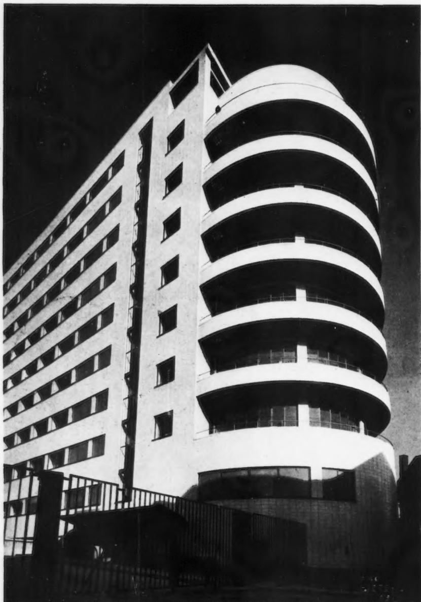
FAÇADE OUEST : AILE D'HOSPITALISATION : ROTONDE DES « SALLES DE JOUR ». 25865
