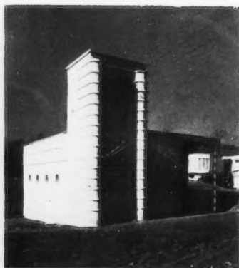
GARAGE ET POSTE DE TRANSFORMATION
