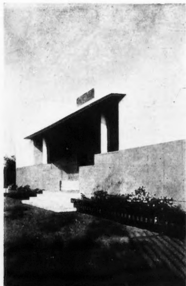
DÉTAIL DE L'ENTRÉE
