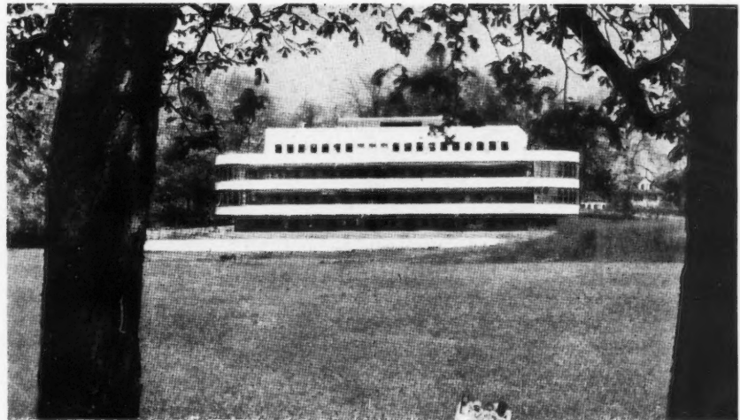
FAÇADE PRINCIPALE (SUD)
