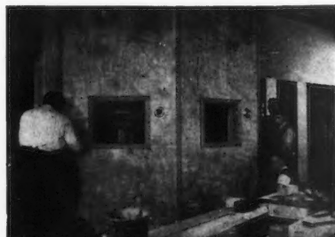
SUR LES CLOISONS
