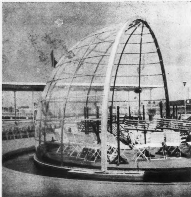
LIÈGE. KIOSQUE ORIENTABLE EN ACIER ET RHODOID SUR FLOTTEURS.
