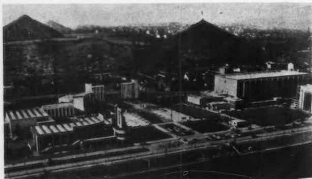
49.886 RIVE GAUCHE UNE CERTAINE GRANDEUR ORDONNÉE RÉSULTE DE L'UNIFORMITÉ DES VOLUMES CONSTRUITS (ET DE LA SIMPLICITÉ DU PLAN DE LA RIVE DROITE)
