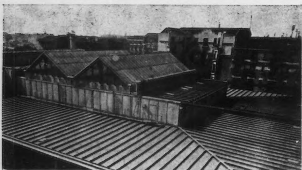
LE COMBLE ROULANT EST EN PLACE. (A droite, on voit les rails de roulement.)
