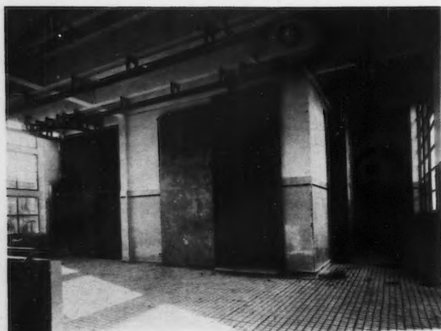
MONTE-CHARGE A L'ENTRÉE. III-IV-30
