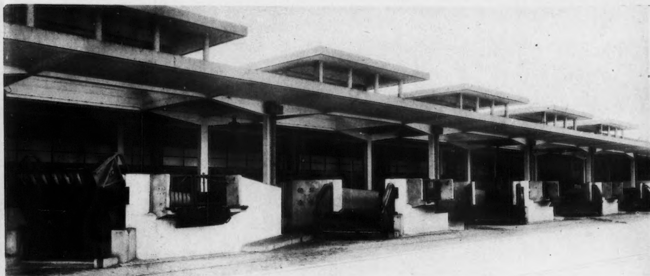
VUE D'ENSEMBLE DES QUAIS D'ARRIVÉE
