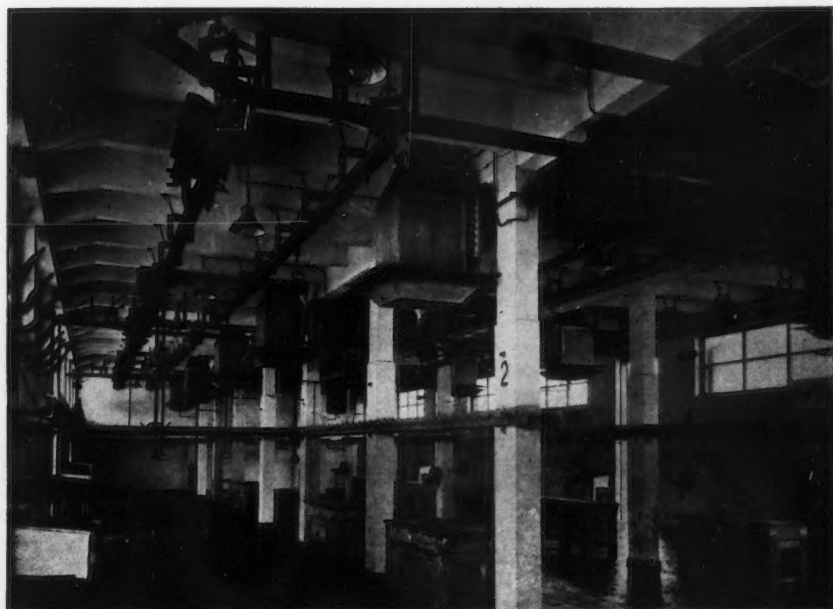
Ci-contre : STANDS DE VENTE DE LA BOUCHERIE Rafraîchis au moyen d'aéro-réfrigérants à circulation de saumure.
