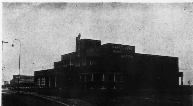
VUE D'ENSEMBLE DU BATIMENT PRINCIPAL.
