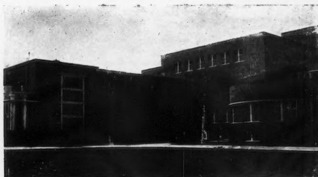
A gauche : LA CHAUFFERIE ET LA SALLE DE MACHINES (à l'étage : L'ARRIVÉE DES ANIMAUX A L'ABATTOIR). A droite : BATIMENT PRINCIPAL (Au 2 me étage : L'ABATTOIR).
