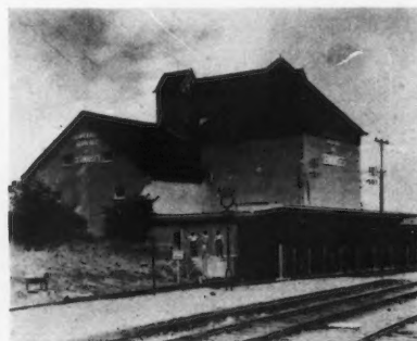
VUE D'ENSEMBLE (COTÉ GARE)
