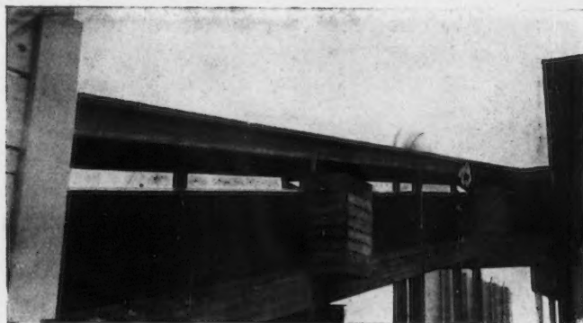
RAMPE MENANT AU DEUXIÈME ÉTAGE.
