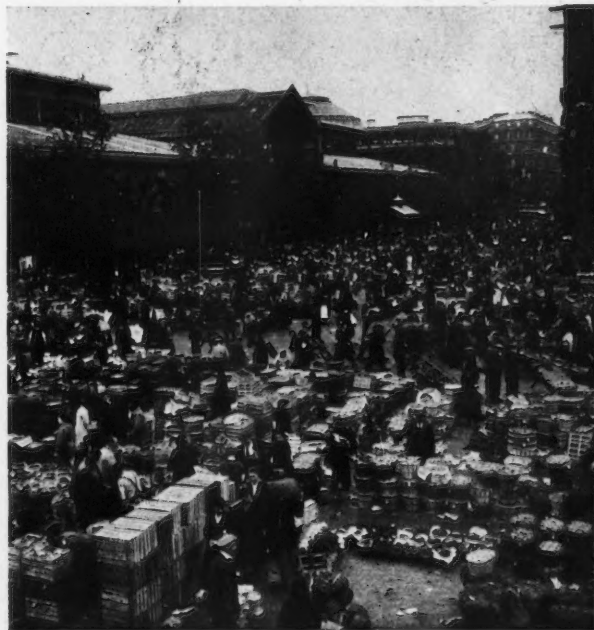
LES HALLES DE PARIS : LE CARREAU.
