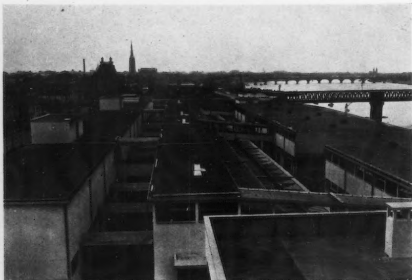
VUE D'ENSEMBLE DE L'ABATTOIR III-IV-28
