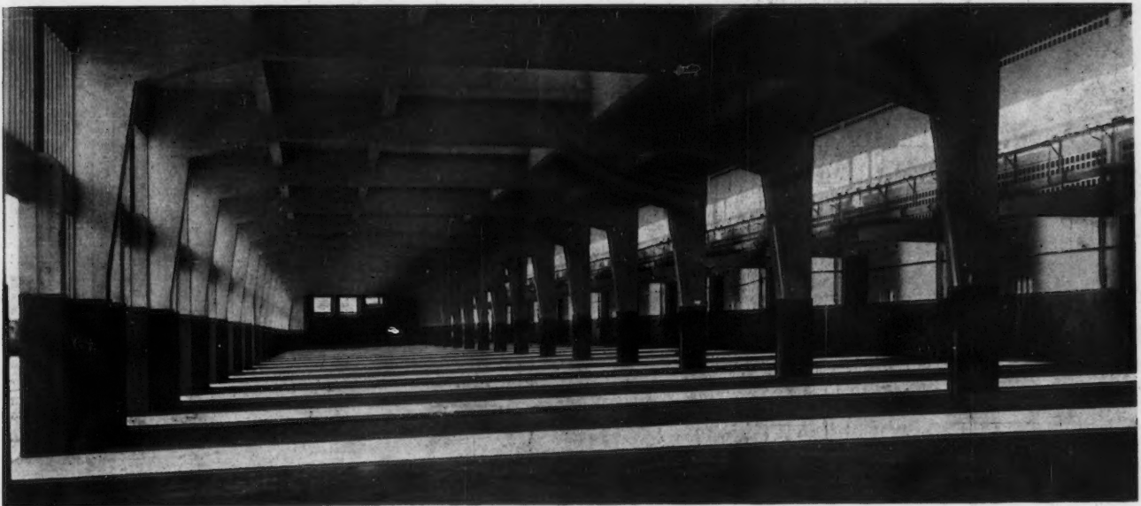
VUE INTÉRIEURE DE LA HALLE DE VENTE
