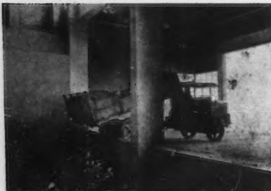
HALL DE DÉCHARGEMENT DES CAMIONS III-IV-68
