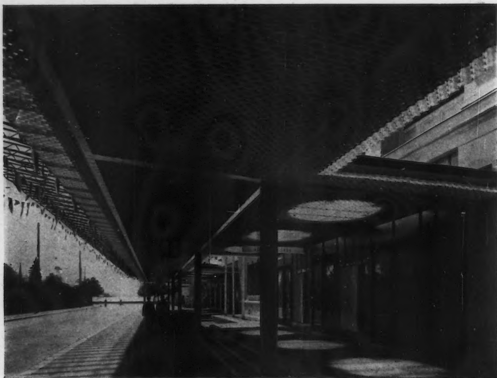
AUVENT AU-DESSUS DES ENTRÉES RELIANT L'ANCIEN ET LE NOUVEAU CORPS DE BATIMENT (Face inférieure revêtue de grilles composées de bandes de tôles ondulées).
