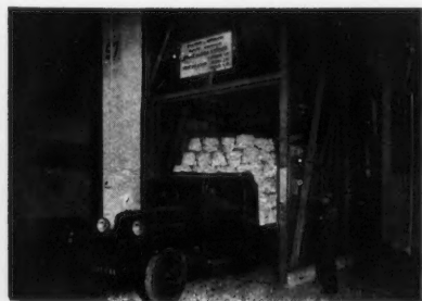
Monte-camion de 8 tonnes reliant le rez-de-chaussée et le deuxième étage du hangar.
