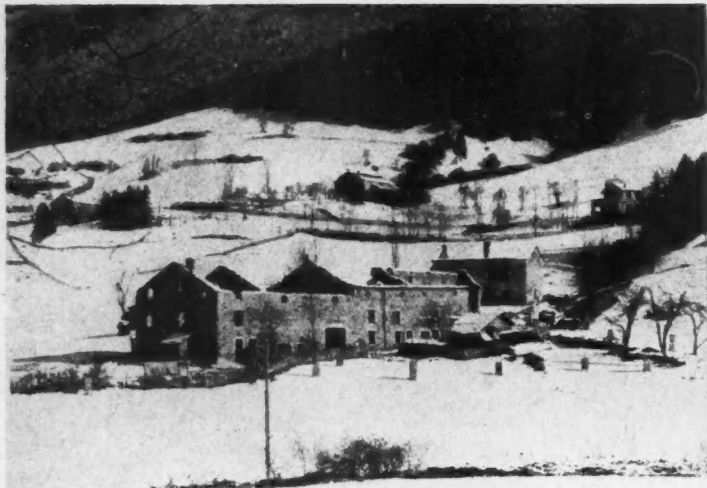
HAMEAU DE LA RIVIERE. Destruction typique du Vercors. La charpente et les planchers ont été incendiés. Les murs sont en partie récupérables.
