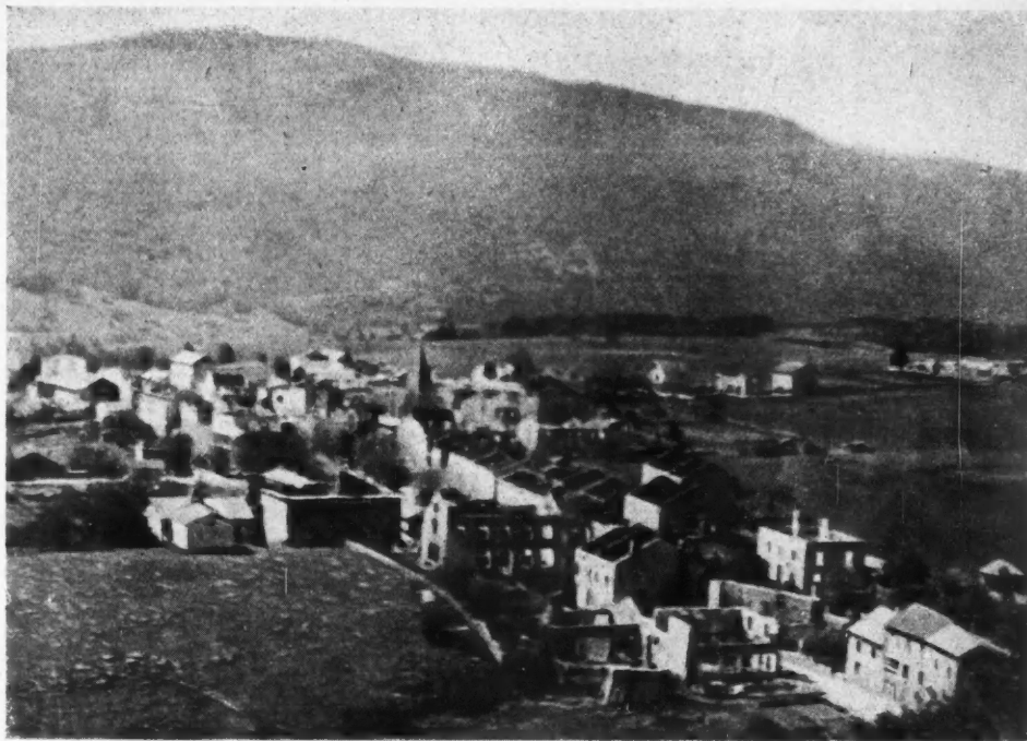
LA CHAPELLE EN VERCORS, VUE GENERALE DES DESTRUCTIONS.
