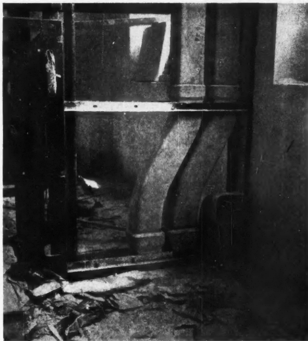
CANALISATIONS DU BLOCEAU. Châssis métallique, gaines de ventilation en fibro-ciment.
