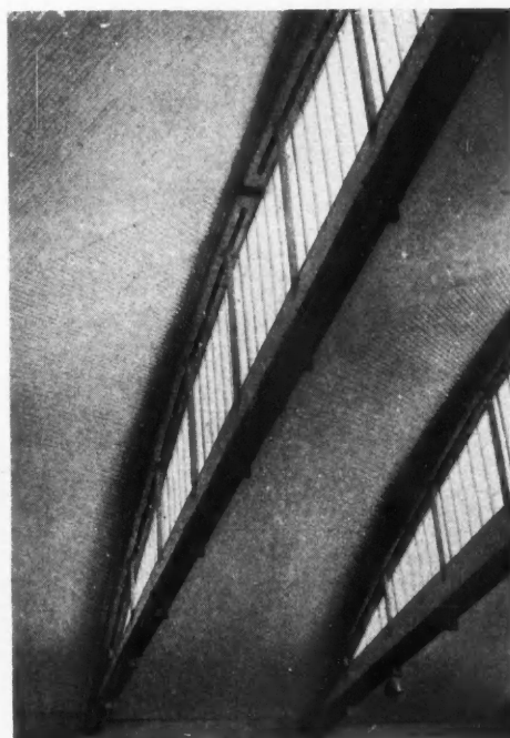
DE HAUT EN BAS : SALLE D'EXPOSITION (3 SUR LE PLAN). LA GALERIE (4). DETAIL DU SHED DU GRAND HALL.
