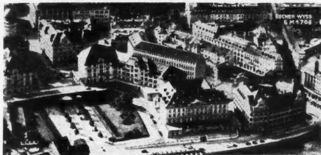
INSTALLATION DE CHAUFFAGE PAR THERMO-POMPAGE DE L'HOTEL DE VILLE DE ZURICH
