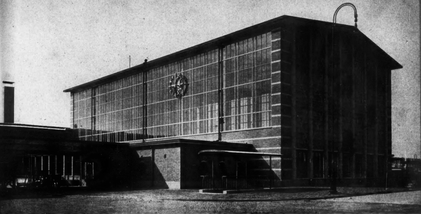
AMSTELSTATION. LE BATIMENT DU GRAND HALL.
