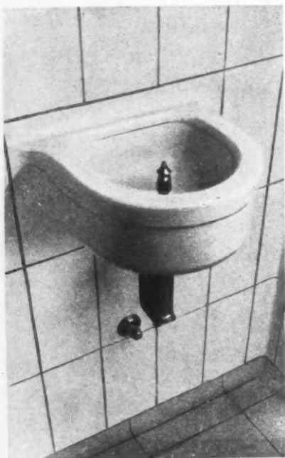
CRACHOIR. Pièce en grès encastrée se raccordant exactement aux carreaux du revêtement.
