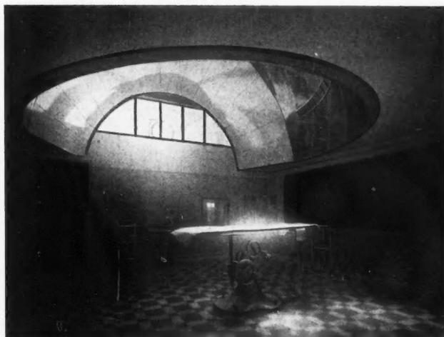
Intérieur de la salle d'opérations. On remarquera entre la voûte et la fenêtre, le cône de raccordement, peint en blanc mat, qui diffuse la lumière du projecteur dans toute la pièce.
