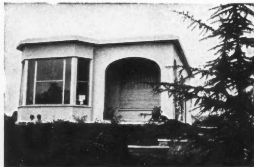
Maison en acier complètement terminée.
