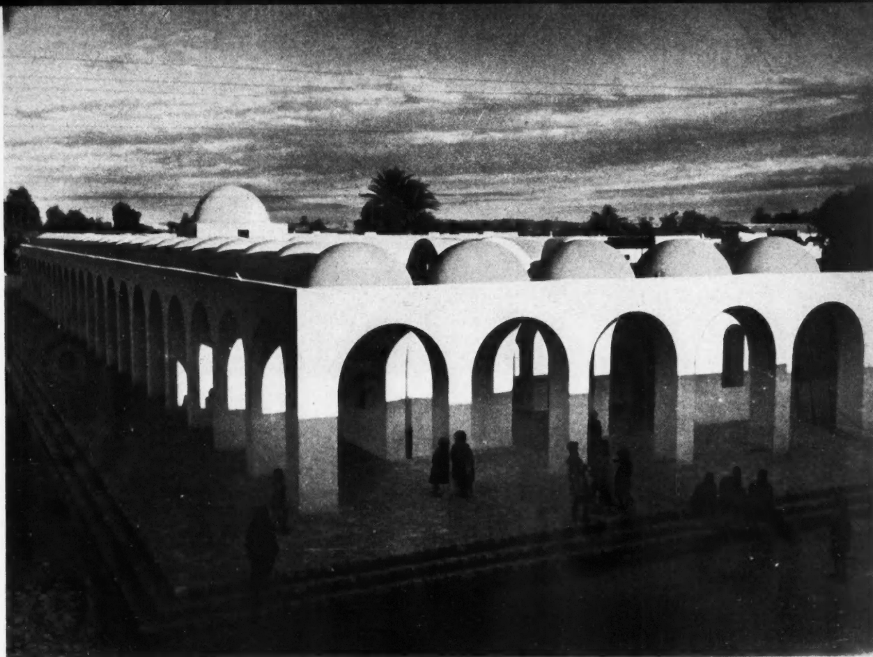
VUE D'ENSEMBLE DU MARCHÉ COUVERT DE SIDI BOU ZID.
