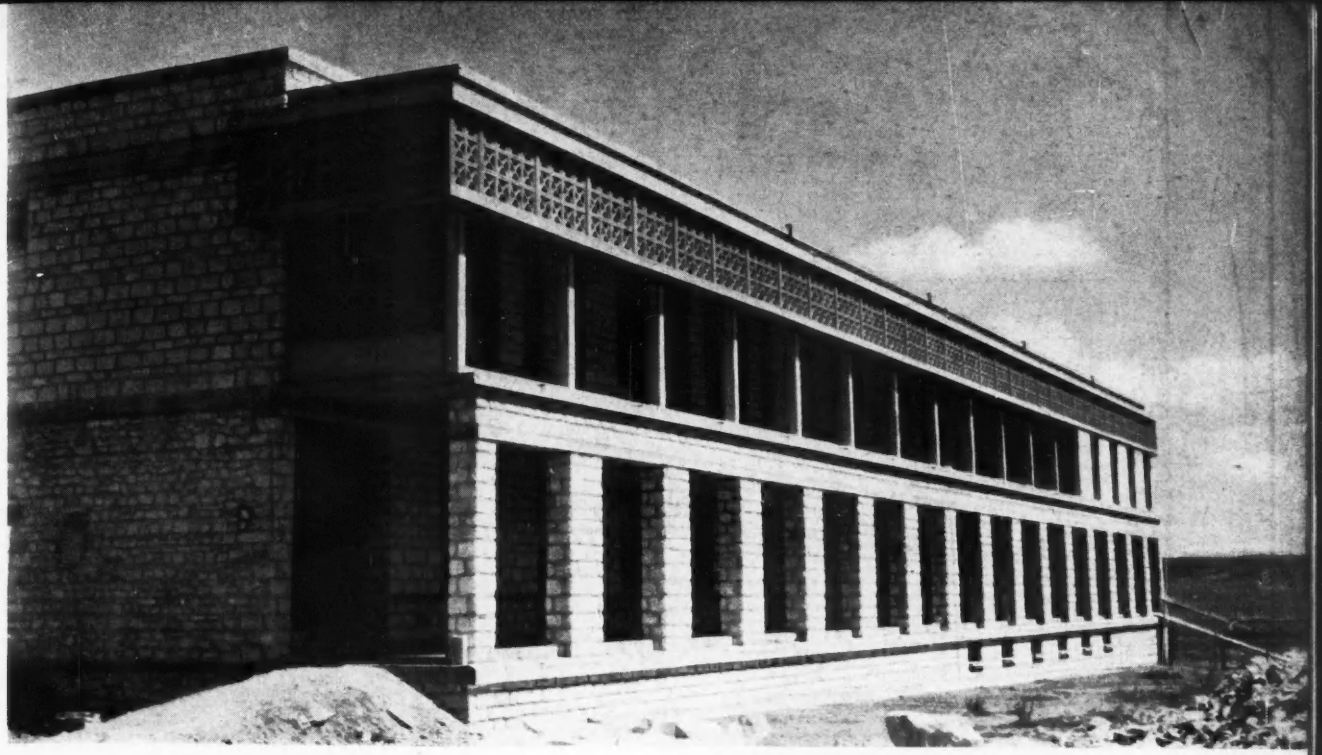
AILE CONSTRUITE FAÇADE SUD-EST
