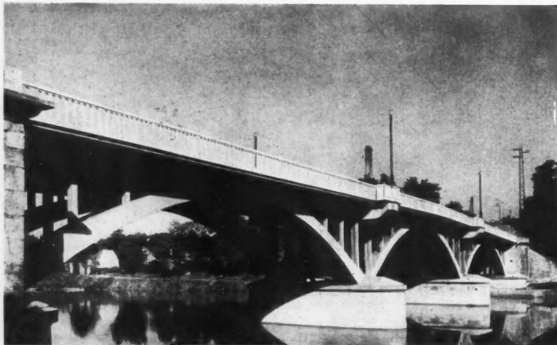
Reconstruction des ponts de LAGNY
