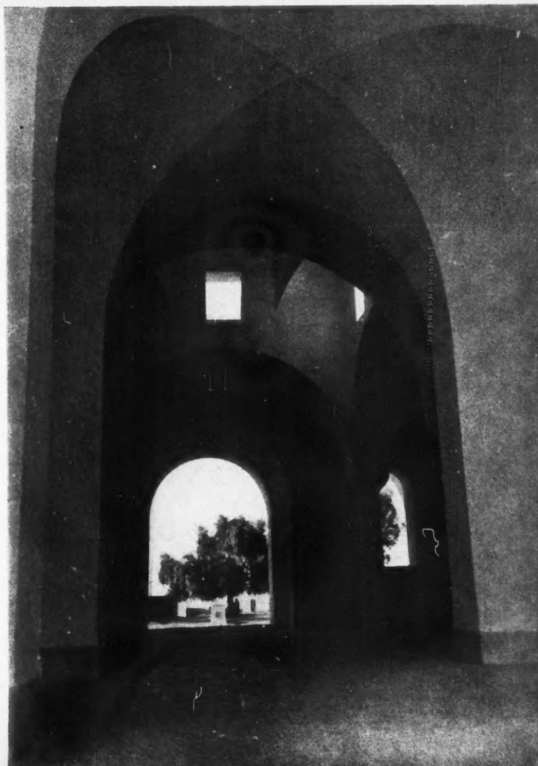
VUE INTERIEURE DE LA COUPOLE CENTRALE
