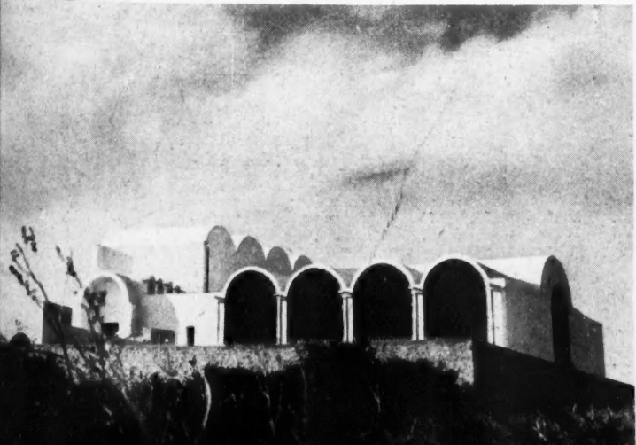
CI-DESSOUS : FAÇADE NORD ET RAMPE D'ACCES
