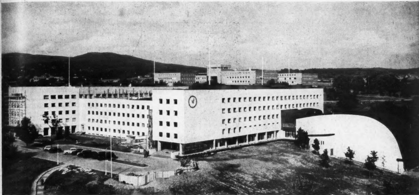
VUE D'ENSEMBLE. AU PREMIER PLAN, A DROITE, LA GRANDE SALLE DE CONCERT. AU FOND, LA CITE UNIVERSITAIRE D'OSLO.
