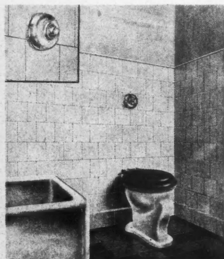
IMMEUBLE « C. B. I. - ESPLANADA »
