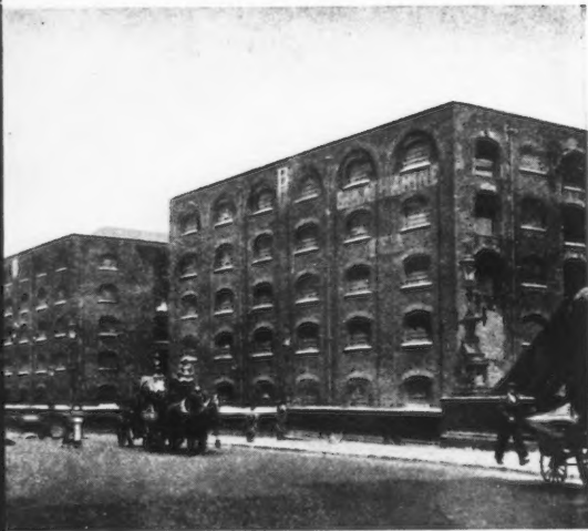
Les docks Sainte-Katherine à Londres (1824-1828). Réalisation de Thomas Treford.
