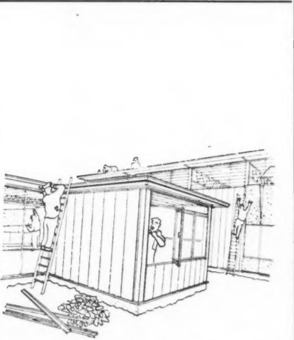
7. Les soffites sont recouverts de panneaux de ciment d'amiante, les fenêtres métalliques sont fixées et vitrées de verre ou de panneau métallique avec laine de verre.
