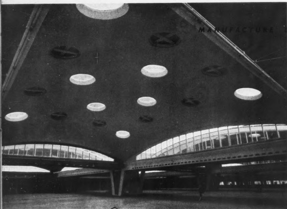
1. Vue Intérieure de l'atelier principal. Éclairage naturel au moyen de lanternes et de tympans vitrés. Chaque couverture mesure 63 ft x 80 ft, soit : 19,25 x 27,50 m ; 2. Coupe-perspective sur le hall de production au niveau de l'étage et 3. Coupe-perspective sur l'atelier de calandrage contigu à l'atelier principal: A Niveau de la production principale; B Dépôt; 1. Gaine de canalisations; 2. Joints de dilatation; 3. Rails du pont roulant; 4. Plafond démontable ou coulissant; 5. Bureau du chef de fabrication; 6. Ventilation; 7. Aération (louvre); 8. Canalisations électriques.
