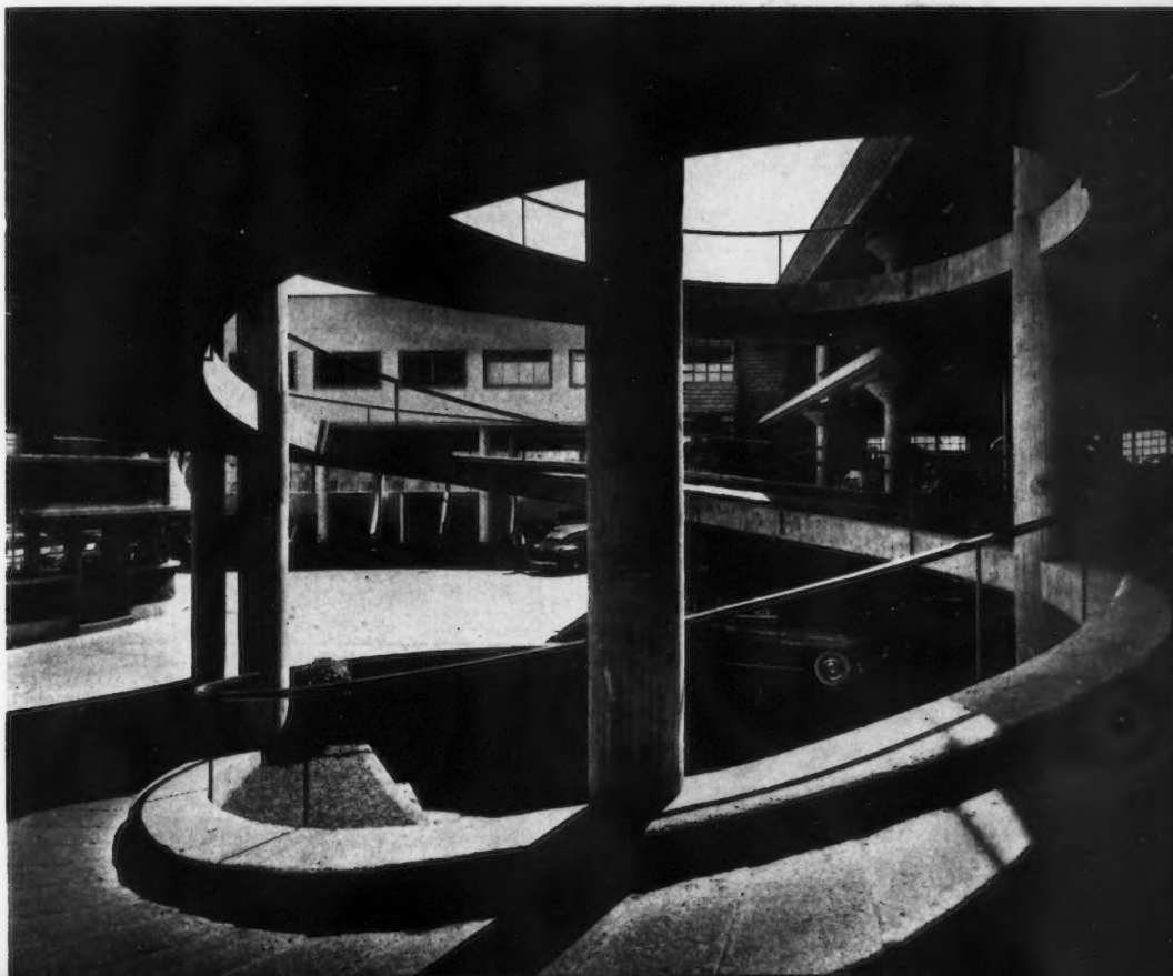
1. VUE DE L'ENSEMBLE. FAÇADE PRINCIPALE VERS LE POSTE D'ESSENCE. AU PREMIER PLAN, LE MAGASIN DE VENTE D'AUTOMOBILES. 2-3. VUES DE LA RAMPE EN BETON ARMÉ.
