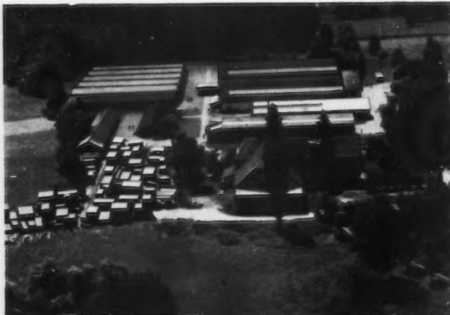
MISCHLER a spécialisé son usine de FRETIGNEY (Haute-Saône) dans la fabrication des fermetures bois.
