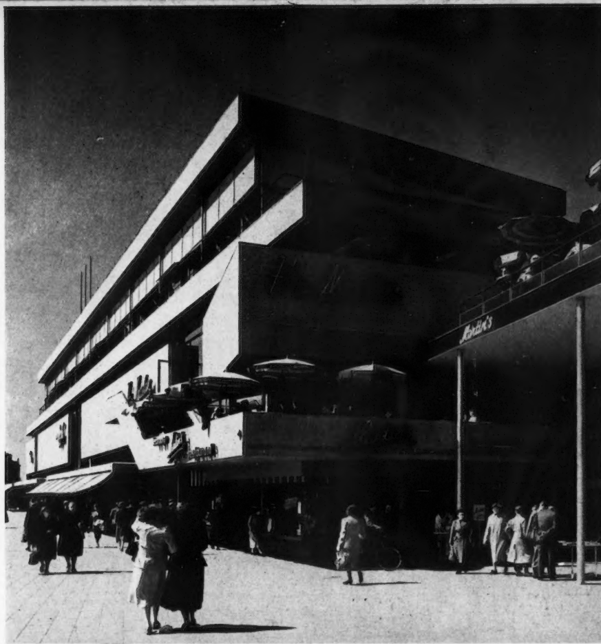
1-2 VUES GENERALES DU MAGASIN. 3. VUE SUR LE RESTAURANT. 4. PARTIE DE FAÇADE VUE DE NUIT. 5. LE MEME DETAIL VUE DE JOUR.
