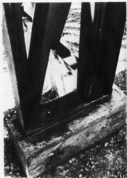
1. Pièces de liaison des arêtiers et empanons de la charpente toiture. 2. Montage de l'ossature. 3. Détail de scellement.
