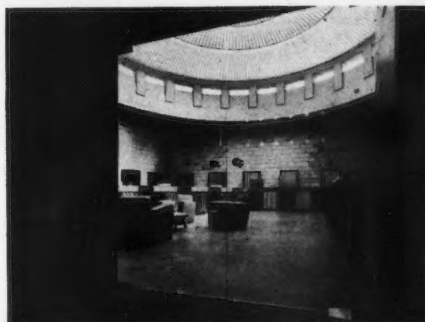
COUPOLE EN BETON TRANSLUCIDE DINDELEUX.
