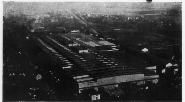
Laminiers de Denain - Usinor - Sous-toitures MINANGOY-POYET avec chape : 90.000 m 2 environ
