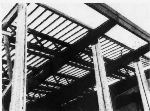
Charpente du préau : poutre principale et détail.
