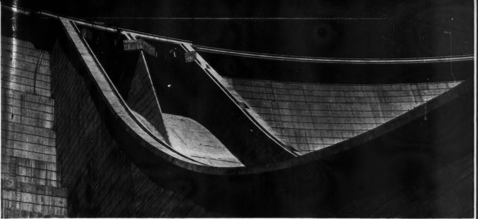
Déversoir de crues en saut de ski.
