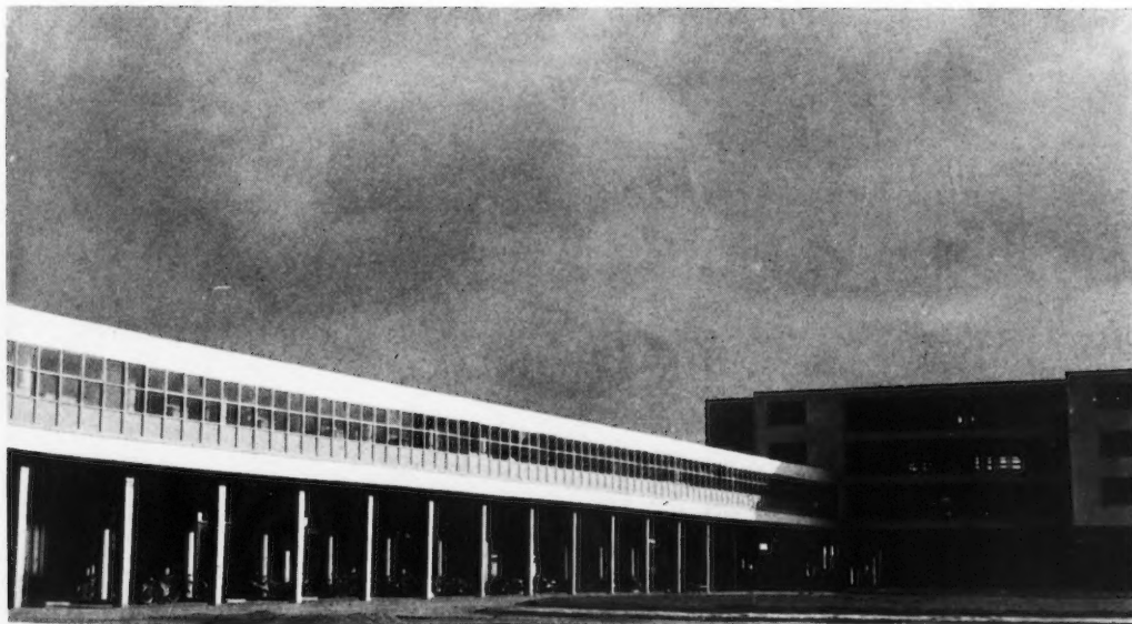
Les vestiaires et un des bâtiments abritant les réfectoires.
