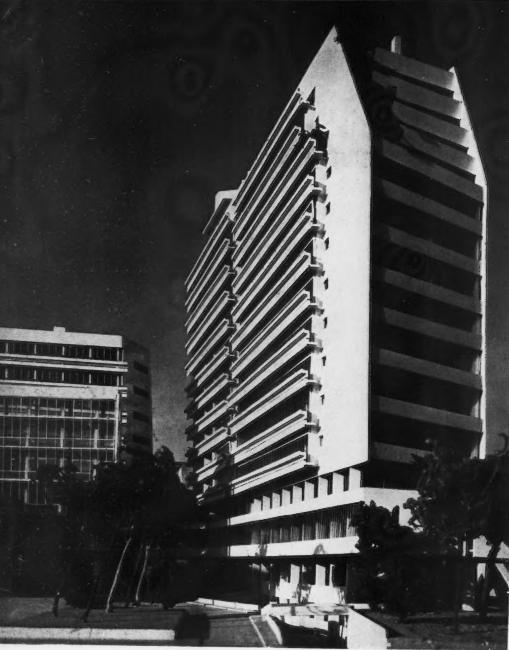
1. Vue de la maquette des bâtiments A. et B. (hauteur 50 m.); 2. Vue de chantier des bâtiments A. et B. en construction; 3. Vue en maquette du bâtiment C.
