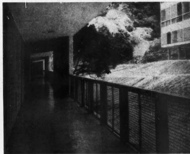
Accès à l'école de l'Unité d'habitation de Pedregulho. Exemple d'interpénétration des espaces extérieurs et intérieurs
