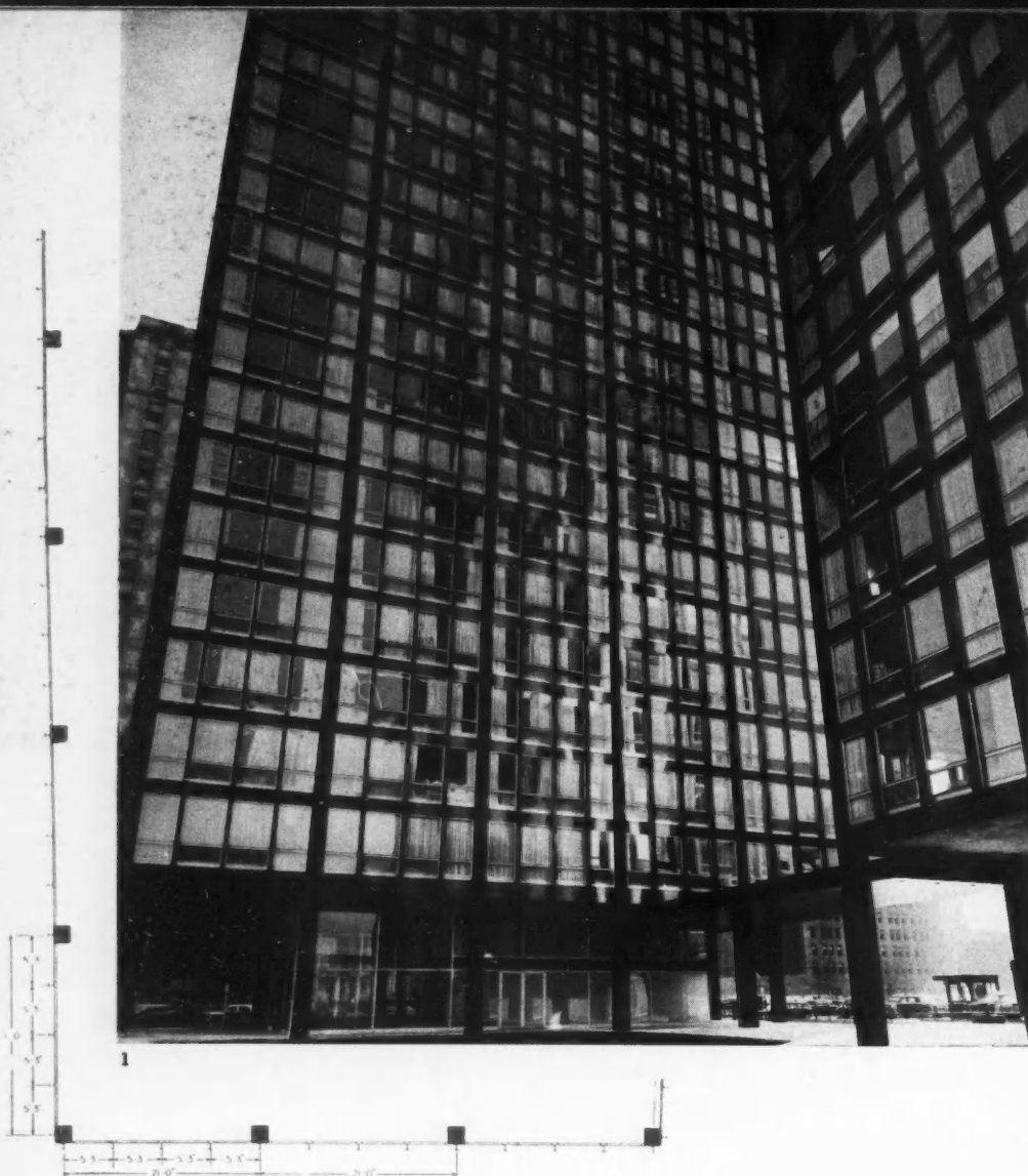
↑ Trames des ossatures principale et secondaire. Disposition ayant pour résultante le rétrécissement des panneaux vitrés d'extrémité de chaque travée.
