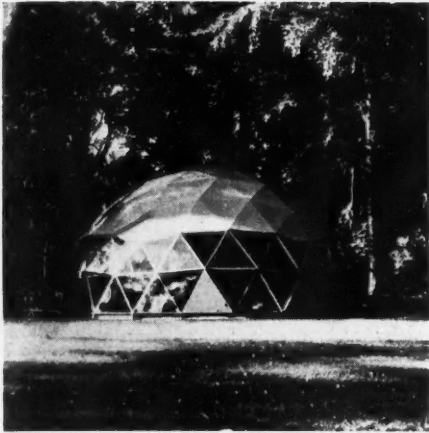
4 et 5. Maison de vacances en éléments de bois et plastic. Diamètre: 9 m., surface de plancher: 50 m 2 ; 6. Maquette d'une habitation. Dans l'espace défini par le dôme se répartissent librement les divers éléments intérieurs.
