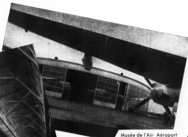
Musée de l'Air- Aéroport du Bourget : 2.500 m 2 M. Granet, architecte
