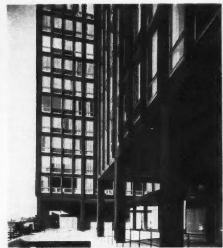
↑ Trames des ossatures principale et secondaire. Disposition ayant pour résultante le rétrécissement des panneaux vitrés d'extrémité de chaque travée.
