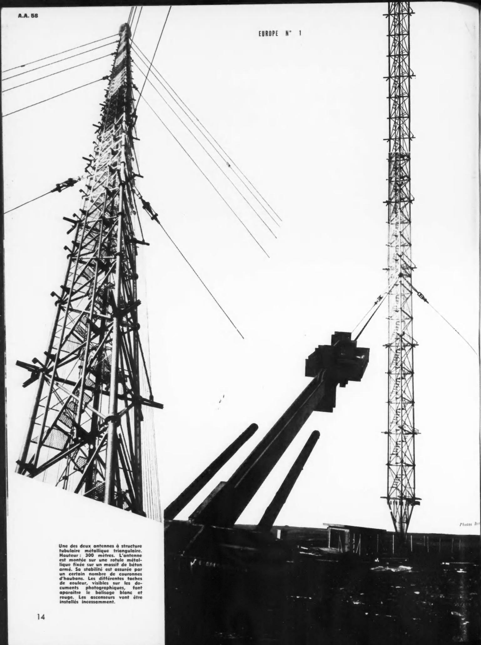
Une des deux antennes à structure tubulaire métallique triangulaire. Hauteur: 300 mètres. L'antenne est montée sur une rotule métallique fixée sur un massif de béton armé. Sa stabilité est assurée par un certain nombre de couronnes d'haubans. Les différentes taches de couleur, visibles sur les documents photographiques, font apparaître le balisage blanc et rouge. Les ascenseurs vont être installés incessamment.
