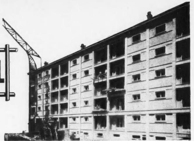
Les planchers des H. L. M. de Pantin sont armés de 30.000 m<sup>2</sup> de Treillis Soudé **Quadrimétal**.
