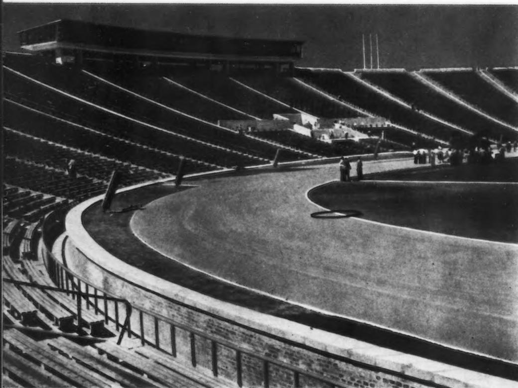
Construction : 1<sup>er</sup> août 1954-22 juillet 1955. Terrassements : 302.000 m<sup>3</sup>. Remblais de terres et de décombres : 1.111.000 m<sup>3</sup>. Travaux routiers : 20.000 m<sup>2</sup> de voies en hexagones préfabriqués, 80.000 m<sup>2</sup> de bitume, 6.000 m<sup>2</sup> de trottoir en dalles de béton et 4.700 m<sup>2</sup> en brique hollandais, 12.000 m<sup>2</sup> de chemins en gravier et 12.000 m<sup>2</sup> de parking en brique hollandaise.
