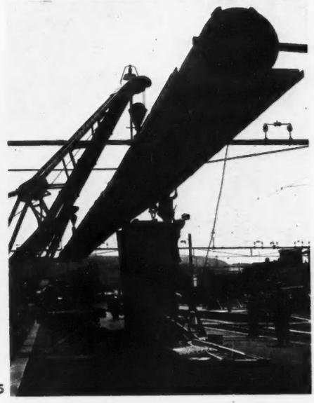
1. Vue de la poutre maitresse en tube d'acier. 2. Vue d'ensemble de l'abri. 3. Transport par train de 60 éléments de dalles. 4. Train transportant cinq éléments de la poutre principale. 5. Montage de cette poutre.
