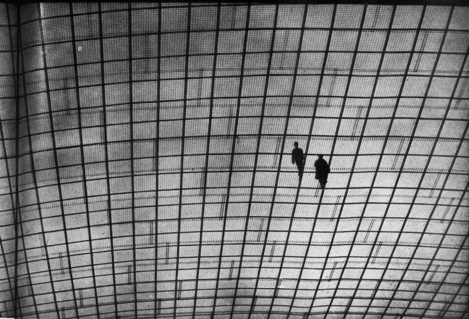
La tension des câbles, constitués de faisceaux de 6 et de 8 ronds de 6 supporte le poids des rives qu'elle sollicite vers le haut si bien qu'un hauban à chacun des trois points hauts suffirait à en assurer la stabilité.
