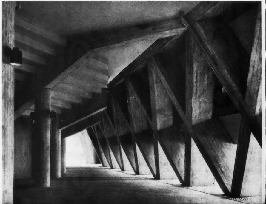
10. Structure en résille de béton armé sur l'un des côtés de l'auditorium. 11 et 12. Deux vues intérieures de l'auditorium.
