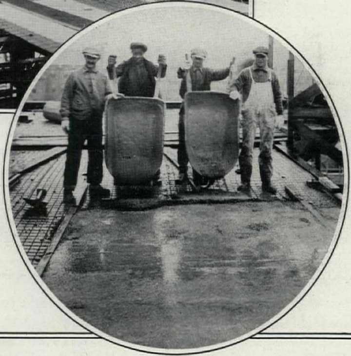
Pouring concrete on STEELTEX
