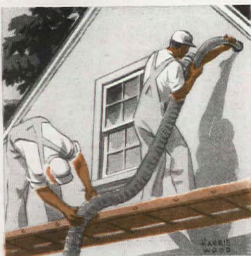
4. Installing loose fill
