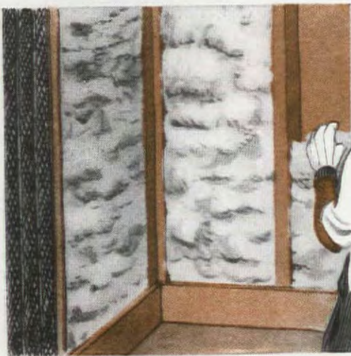
4. Installing loose fill
