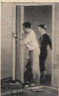
Fit jamb post over clips
