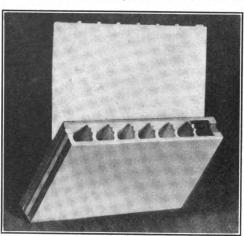
Novelties .- Fig. 7 .- Dodd's Interlocking Plaster Blocks.
