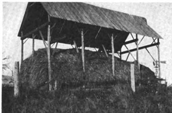
Fig. 4—A Cedar Pole Hay Shed
