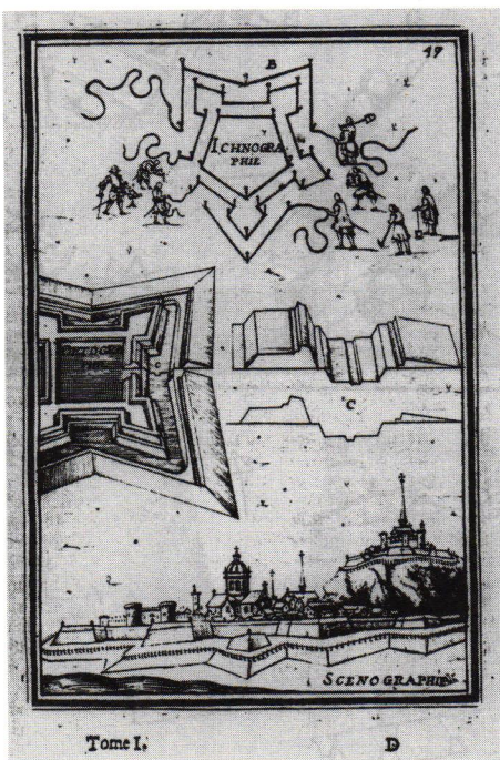
A page from Manuel d'un ingénieur-architecte du début de XVII e siècle, labeled, from top to bottom, "ichnographie, orthographie, scénographie." (From La gloire des ingénieurs .)
