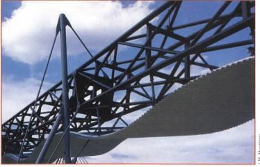
VIEW OF UNDULATING CANOPY SUSPENDED FROM BOX FRAME
