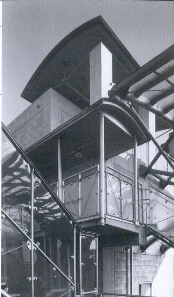
ジスタス4F通路 および住戸テラス屋根
