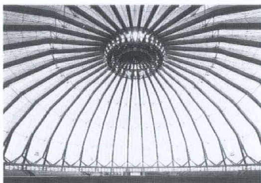
出雲ドーム(木造ドーム) 大空間に日本の伝統美を生かした木造とスチールによるハイブリッド構建造。
