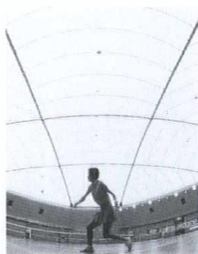
クリエイティブ・テニスガーデン千葉(エアドーム) 膜屋根を空気です支えるため超大スパンにも対応が可能、戸外のような明るい大空間。
