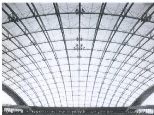
あきたスカイドーム(スーパーパラソル・ドーム) 自然光を透過する膜屋根とスチール造のスーパー・スペースアーチによるハイブリッド構建造。
