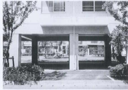
道から電蛇平団地の中庭を見る
