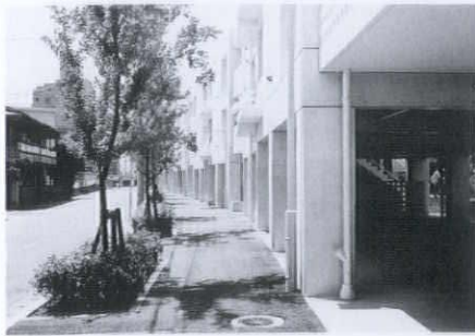
電蛇平団地の道に沿ったピロティ
