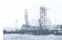
12: シーバース 1: 千葉市美浜区新港231 3: 高さ15m
