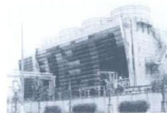
7: 日本触媒化学冷却塔 1: 川崎市川崎区千鳥町 2: 日本触媒化学 3: 高さ15m
