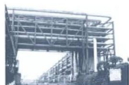
2: 東亜燃料・パイプライン 1: 川崎市川崎区浮島町 2: 東亜燃料 3: 高さ15m
