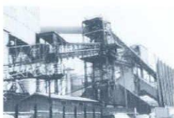
1: 大阪セメント・コンベア 1: 横浜市鶴見区大黒町 2: 大阪セメント 3: 高さ20m
