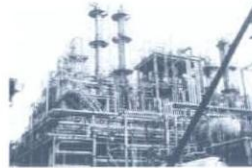
10: 昭和電工川崎工場 1: 川崎市川崎区扇町 2: 昭和電工 3: 高さ20m
