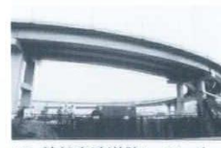
15: 首都高速道路レインボーブリッジ・ループ高架 1: 東京都港区港南 2: 首都高速道路公団
