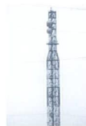
14: 通信塔 1: 千葉市美浜区磯辺 3: 高さ80m
