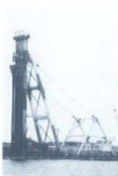
7: サンドコンパクション船 1: 習志野市茜浜 2: 不動建設 3: 高さ60m
