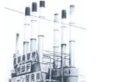
10: グリーン開発産業廃棄物焼却炉 1: 市川市高谷 2: グリーン開発 3: 高さ20m
