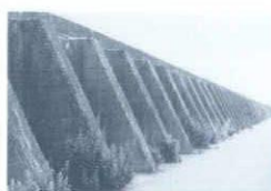
10: 護岸 1: 船橋市日の出2 3: 高さ3.5m
