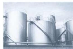
12: ゼネラル石油貯油所タンク 1: 川崎市川崎区安善町 2: ゼネラル石油 3: 高さ9m
