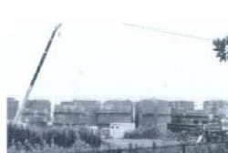
4: 若洲のタンク 1: 東京都江東区若洲 3: 高さ10m
