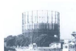
13: モービル石油・貯油タンク 1: 川崎市川崎区安善町 2: モービル石油 3: 高さ40m
