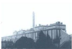
2: 東京電力横浜火力発電所 1: 横浜市鶴見区大黒町 2: 東京電力 3: ボイラ高さ50m
