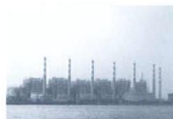
6: 東京電力川崎火力発電所 1: 川崎市川崎区千鳥町 2: 東京電力 3: ボイラ高さ50m
