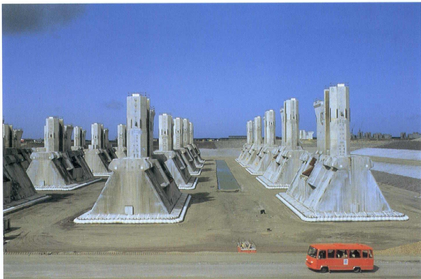
人工島のドッグで建造中の橋脚
