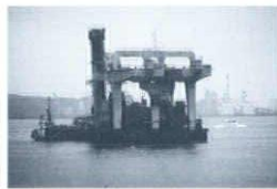
3: 運搬される橋脚 1: 東京都江東区若洲 3: 高さ15m
