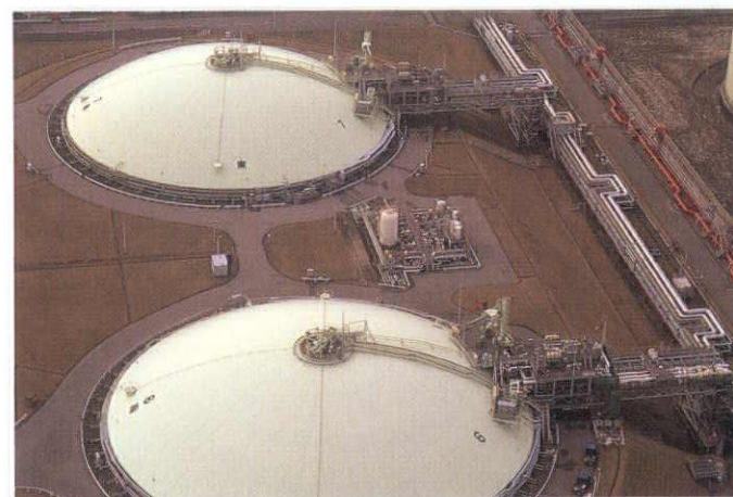
LNG地下貯蔵槽
