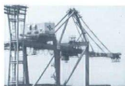
8: 青海コンテナターミナルのコンテナクレーン 1: 東京都江東区青海2
