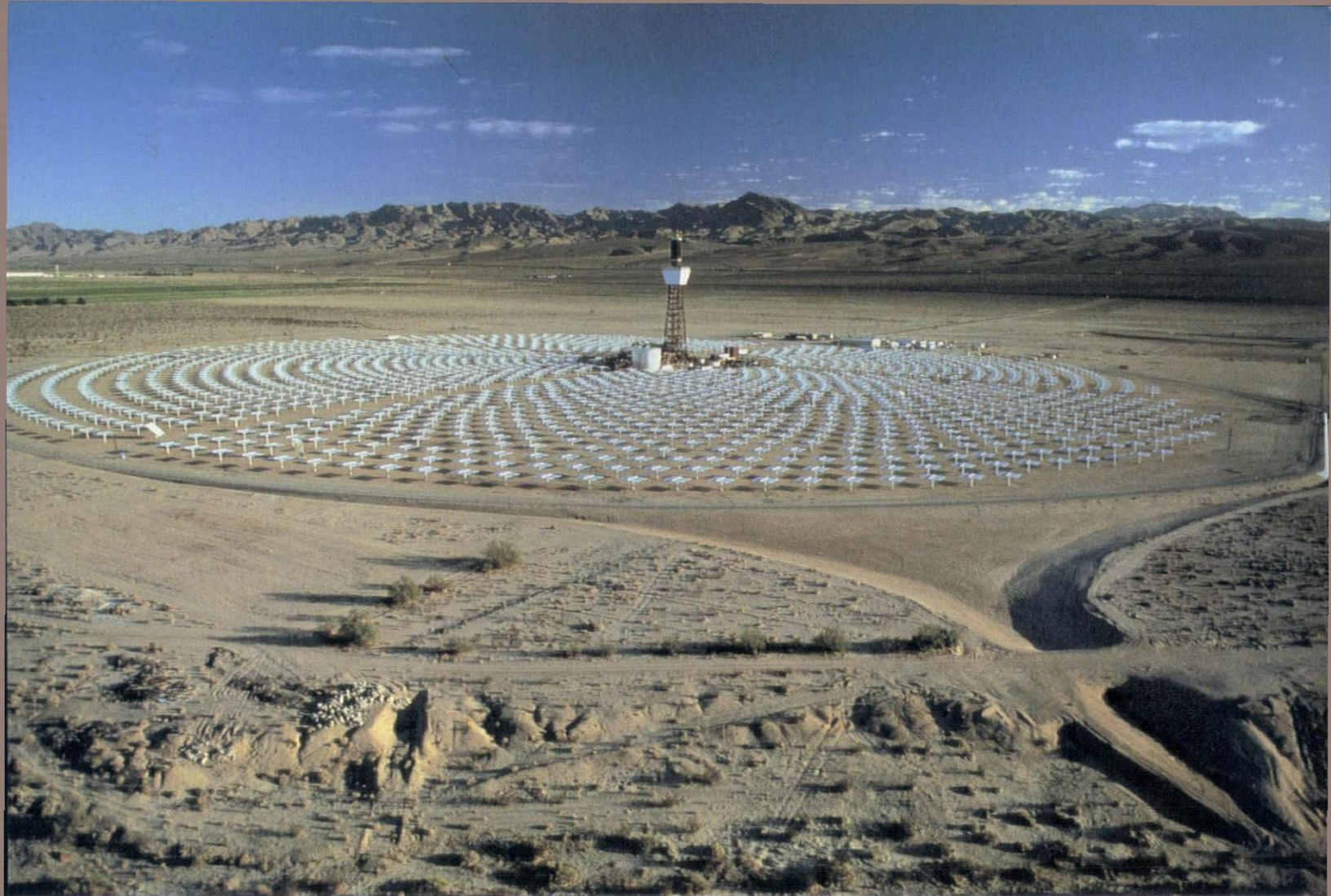
ソーラー・ワン、アメリカ、カリフォルニア州 太陽熱発電施設。1818 基の太陽軌道追跡型反射鏡の光が中央の集光器に集まり、 摂氏 600°Cの水蒸気を生み出す。 Solar 1, California, USA
