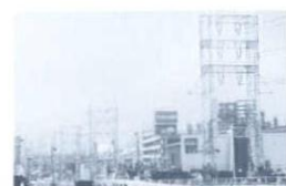
4: 浮島町の高圧送電線鉄塔 1: 川崎市川崎区浮島町 3: 高さ30m
