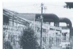
12: 三菱製鋼東雲工場 1: 東京都江東区東雲1 2: 三菱製鋼 3: 高さ15m
