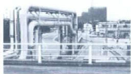
1: 川崎製鉄、東京電力千葉火力発電所パイプライン 1: 千葉市中央区蘇我町2 2: 川崎製鉄、東京電力 3: パイプ直径1.5m
