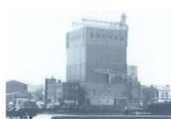
8: 横浜新港倉庫 1: 横浜市中区山下埠頭 3: 高さ25m
