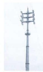
15: 送電線鉄塔 1: 習志野市芝園3 3: 高さ20m
