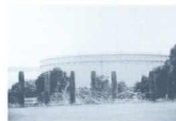
13: 日本石油精製根岸油槽所 1: 横浜市中区豊浦町 2: 日本石油精製(株) 3: 高さ40m
