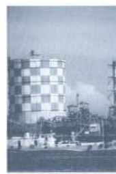
11: 日本鋼管京浜製鉄所タンク 1: 川崎市川崎区扇島 2: 日本鋼管 3: 高さ30m
