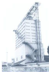
7: 東日本組合飼料サイロ 1: 千葉市美浜区新港19 2: 東日本組合飼料 3: 高さ20m
