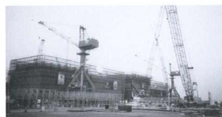
建設中のケーソン
