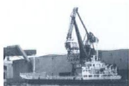
2: 高谷新町岸壁のクレーン、京葉鉄鋼埠頭倉庫 1: 市川市高谷新町 3: 倉庫、幅×奥行=300×100m
