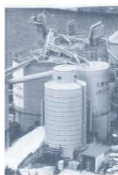
5: 三菱マテリアル・セメント工場 1: 千葉市中央区中央港1 2: 三菱マテリアル 3: 高さ20m
