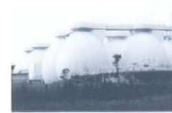
15: 横浜北部第二下水処理場卵型消化槽 1: 川崎市川崎区末広1 2: 横浜市下水道局 3: 高さ20m
