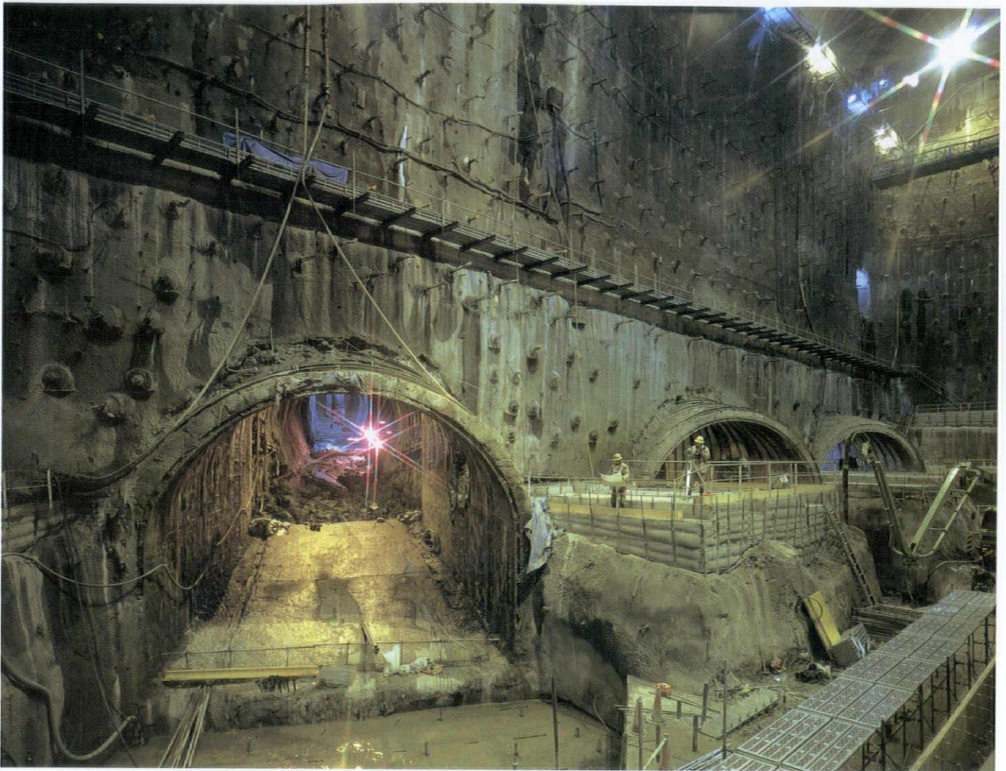
塩原発電所（工事中）
