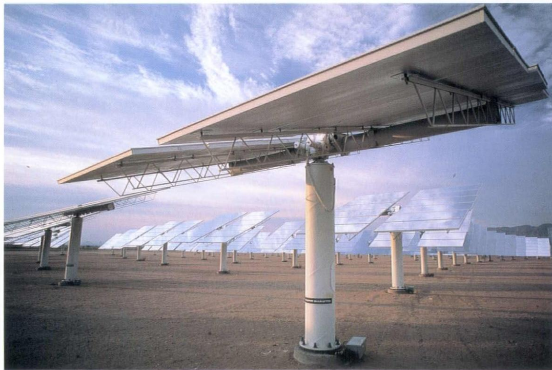
ソーラー・ワン、アメリカ、カリフォルニア州 太陽熱発電施設。1818 基の太陽軌道追跡型反射鏡の光が中央の集光器に集まり、 摂氏 600°Cの水蒸気を生み出す。 Solar 1, California, USA
