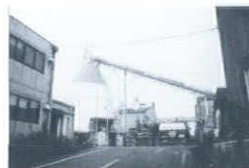
6: 東京ポート工業・コンベア・タンク 1: 東京都江東区新木場 2: 東京ポート工業 3: 高さ20m
