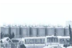
4: サッポロビール発酵タンク 1: 船橋市高瀬町2 2: サッポロビール株式会社 3: 高さ15m、直径5m
