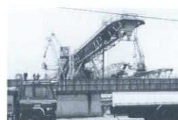
13: 石炭埠頭のベルトコンベア 1: 東京都江東区豊洲6 3: 高さ25m
