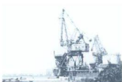
4: 昭和軽金属ジブクレーン 1: 横浜市神奈川区恵比須町 2: 昭和軽金属 3: 高さ20m
