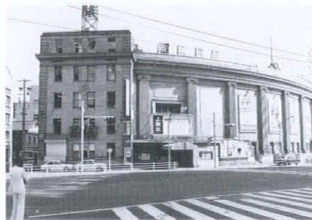
旧神戸証券取引所(現存せず) 様式建築の名手渡辺節が手がけた、浪花町60番にあって、湾曲した壁面にアイオニックの大オーダーが並び偉観を呈していた。現在新築された朝日会館の低層部として旧館のイメージが見られる。
