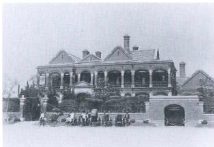
神戸クラブ 神戸にきたイギリス人建築家A.N.ハンセルが設計した最初の建物。東遊園地の南側に外国人達の社交クラブとして建設された。1890年の建築。
