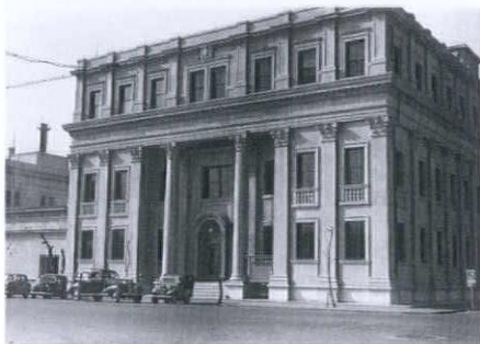
日本銀行神戸支店(現存せず) 京町の中心部に建つこの建物は、明快なルネッサンス・スタイルで、1927年、長野宇平治の設計で完成した。日銀の支店は永らく神戸に置かれていなかったもので、この建物の完成は、神戸の経済基盤の発展に貢献する。
