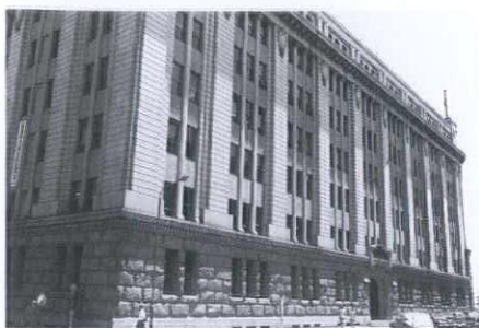
大阪商船神戸支店(現大阪商船三井船舶神戸支店) 海岸通り5番に建ったこの建物は、荒々しい花崗岩によるルスカ仕上げの1階部分を基礎とした三層構成で、大オーダーの上部にはエンブレム(紋章)を配し、コーニスには、齒飾りを付け、装飾性を豊かに持っている。
