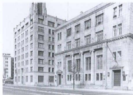
神港ビル(左)とチャータード銀行 海岸通り8番、9番に建てられた。神港ビルは、川崎汽船がオーナーで、太平洋戦争突入直前の1939年の建設。チャータード銀行は京町からこの地に進出し、1938年頃完成した。現在でも神戸の海岸通りに残る昭和初期の建築として昔日の面影を留めている。
