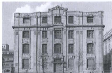
旧三井物産神戸支店(現海岸ビル) 海岸通り3番、4番に建つこの建物は、鉄筋コンクリートと煉瓦造との併用の構造であり、セセッションの雰囲気を持っている。河合浩蔵の設計。1919年に完成した。
