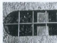
鉄筋・配管が残された破碎後の床
