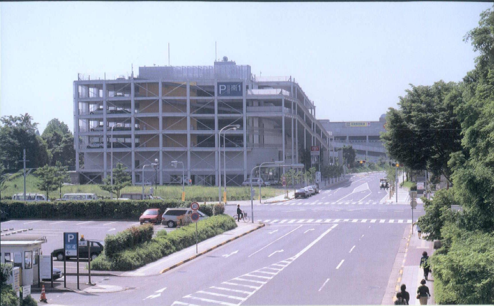
つくば南駐車場 設計=伊東豊雄建築設計事務所 撮影=大野 繁
