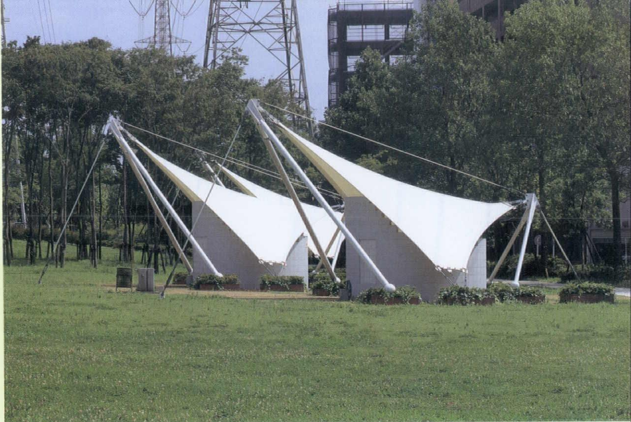
SYP(新横浜駅前公園便益施設) 設計=鈴木和貴/PAX建築計画事務所 撮影=堀内広治
