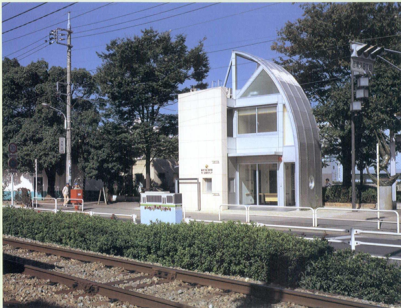
荒川遊園前交番 設計＝平倉直子建築設計事務所 撮影＝堀内広治
