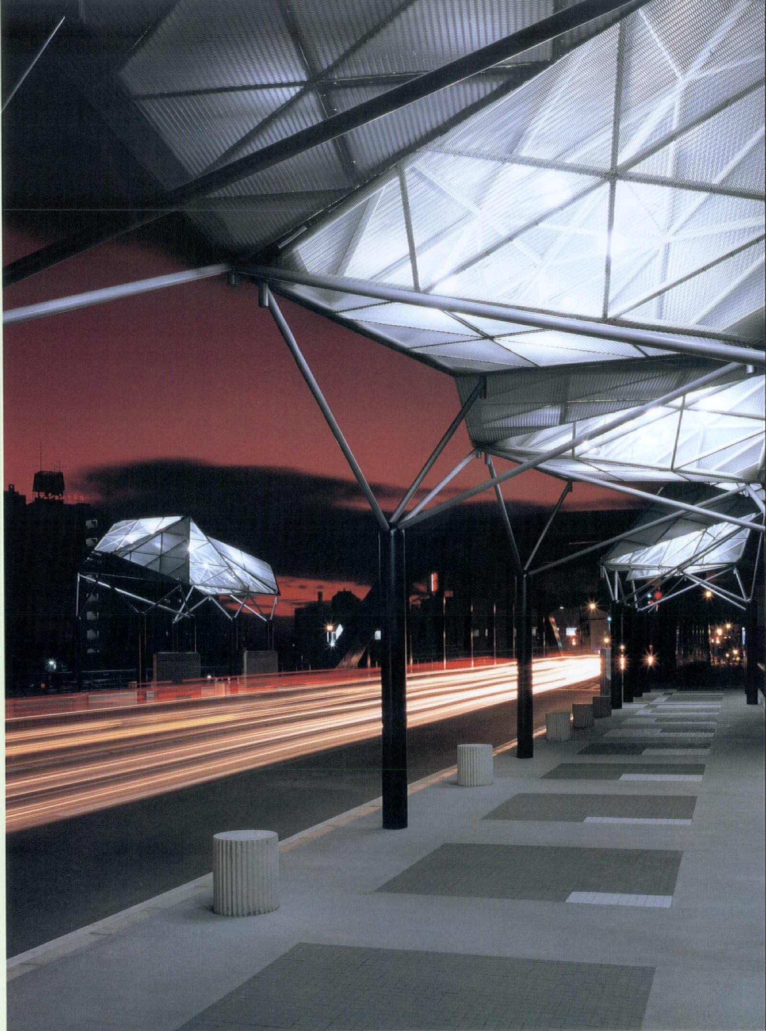
白川橋景観整備 設計＝藤江和子アトリエ 撮影＝大野 繁
