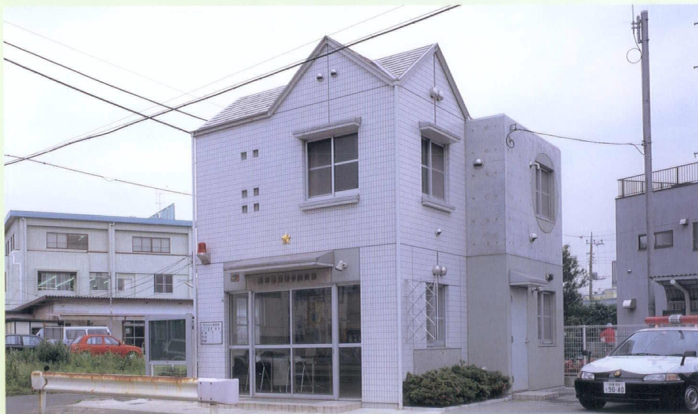
愛川町中津交番 設計＝北村修一／キタムラ・アソシエイツ 撮影＝堀内広治
