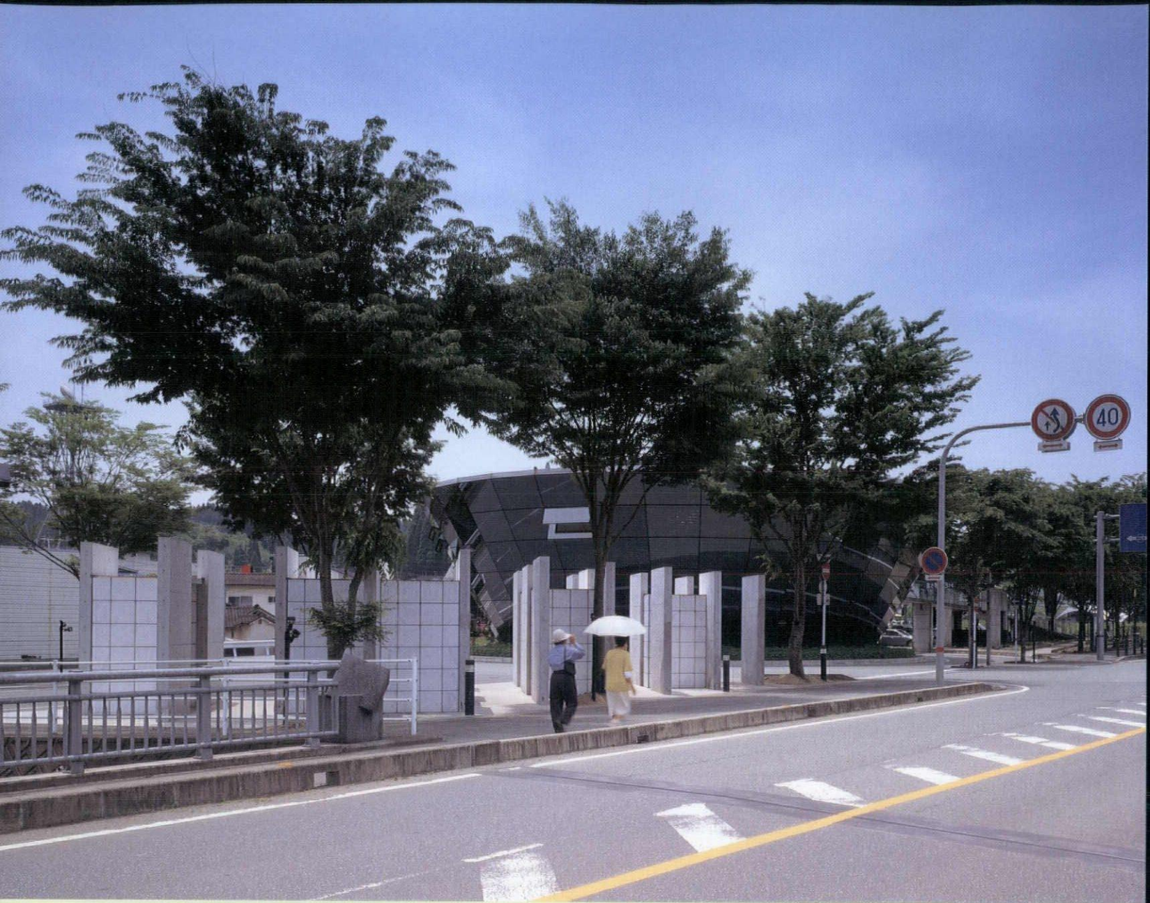
ゆうステーション屋外トイレ 設計＝葉デザイン事務所 撮影＝大野 繁
