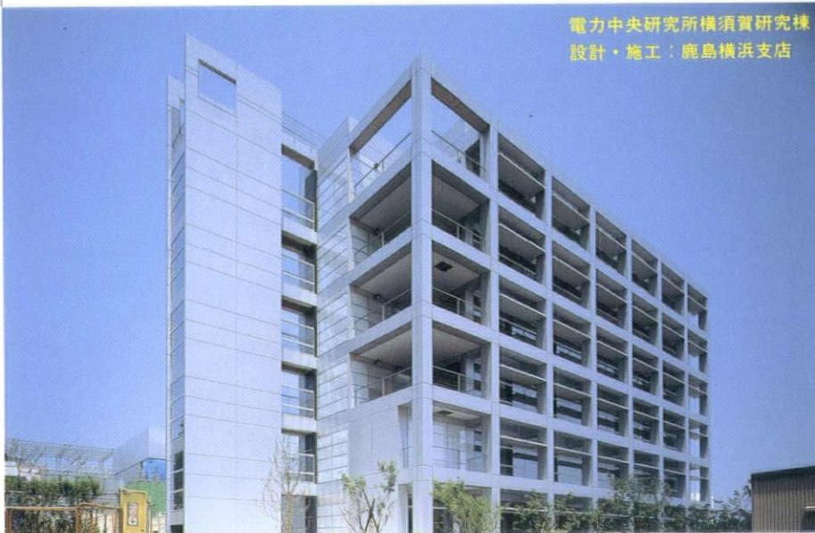
独立柱梁（現場打込み永久型枠）：フッ素樹脂メタリック塗装CFRC
