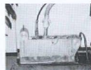
床コンクリート破碎状況(カバー内)
