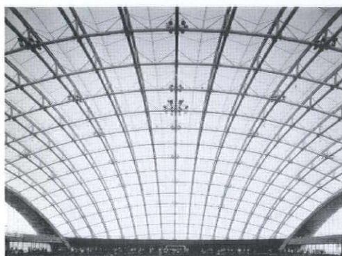
あきたスカイドーム(スーパーパラソル・ドーム) 自然光を透過する膜屋根とスチール造のスーパー・スペースアーチによるハイブリッド膜構造。
