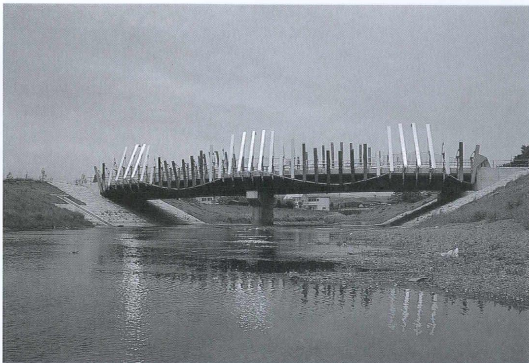
所在地：宮城県白石市鏡子ヶ森地内 主要用途：橋 構造設計：アジア航測 主体構造：S造 規模：最高高さ6.5m 竣工：1989年11
