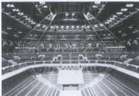
新国技館(スチールトラス)
