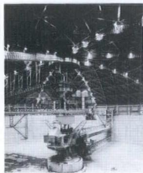
竹原火力発電所貯炭場内部(ラメラドーム)
