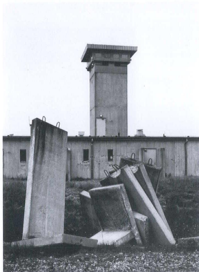
改築前の荒れ果てた旧ミサイル基地管制塔とその施設
