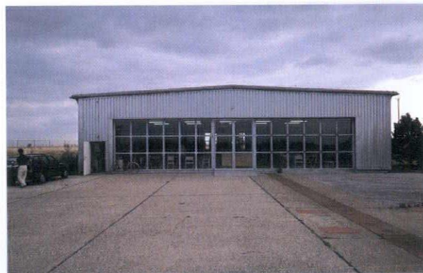
亜鉛板で覆われたミサイルの格納庫の現在の状態
