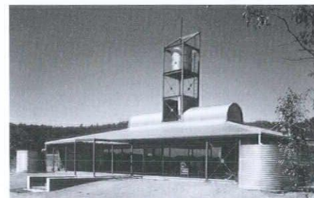
9.ユーゴラのファームハウス ジョン・アンドリュース設計1980年 ジョージアン・ハウスの趣を持つコルゲート網の建築
