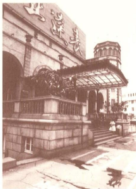
エントランスまわりの現況
