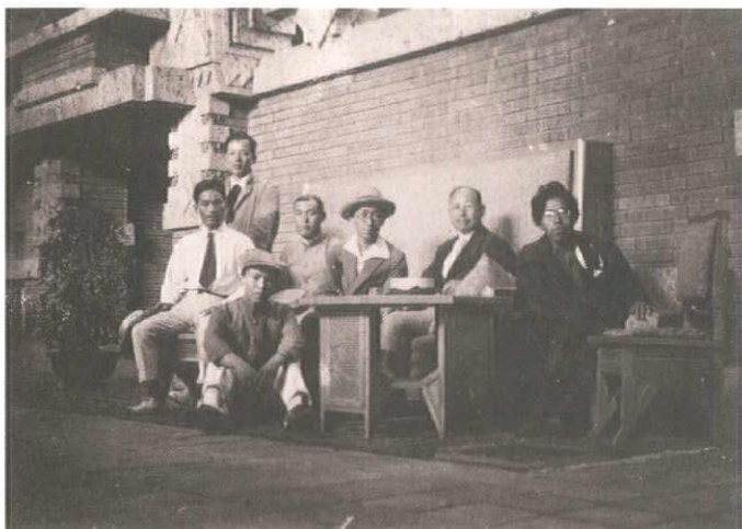
帝国ホテルの工事現場
