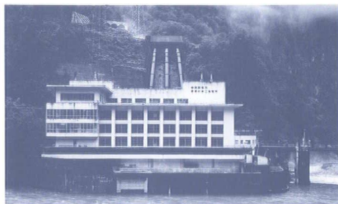
黒部川第二発電所（山口文象 昭和11年）
