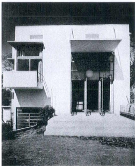
改築前の南側外観
