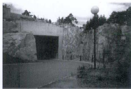
ヴィーキンマキ下水処理場の地下処理場入口
