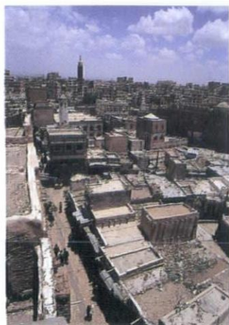
スークゾーンの建物は低層なので上から臨めばその区別はすぐ出来る
