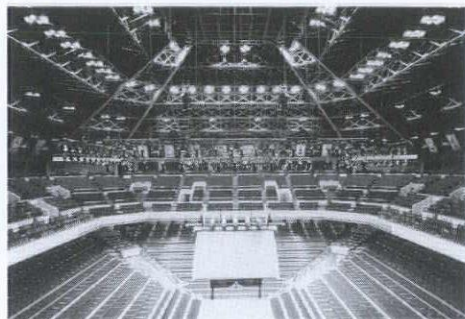
新国技館(スチールトラス) 多様な設計条件にフレキシブルに対応できる豊富なトラス技術ラインナップと建設実績。
