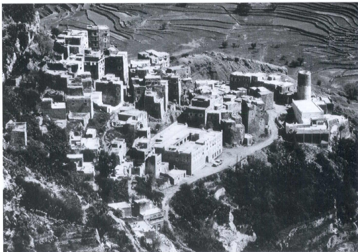
クーランの中心部、円筒形の監視塔とモスク。その周辺はスークゾーンとなっている。
