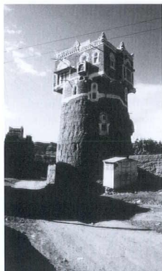
ワディ・ダハールの監視塔に付加させた住居
