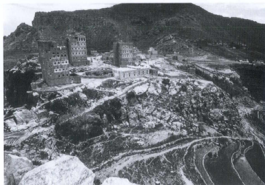
城塞都市部分からモスクの建つ反対側を見る。車はここまでアプローチできる。
