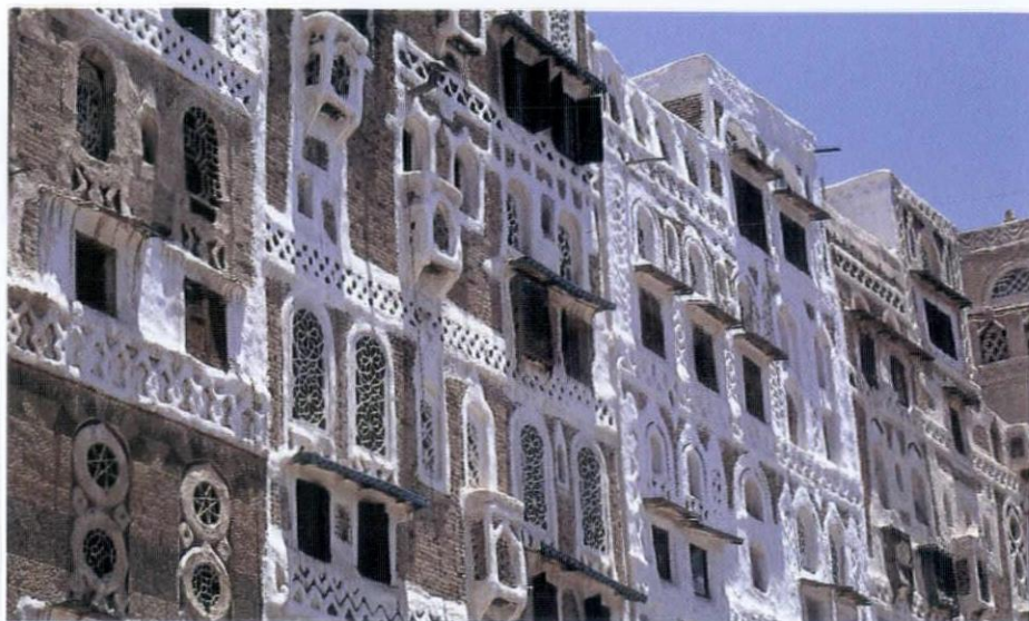
高層住棟が連棟している。思い思いに窓を作っている。
