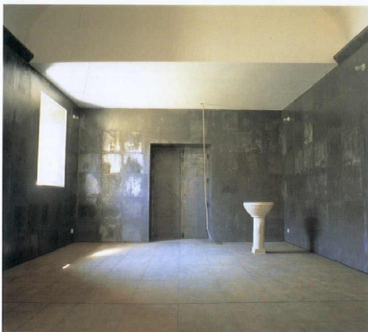
鉛が貼られた内部西側の壁と扉
