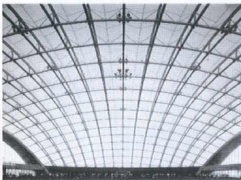
あきたスカイドーム(スーパーパラソル・ドーム) 自然光を透過する膜屋根とスチール造のスーパー・スペースアーチによるハイブリッド構造。
