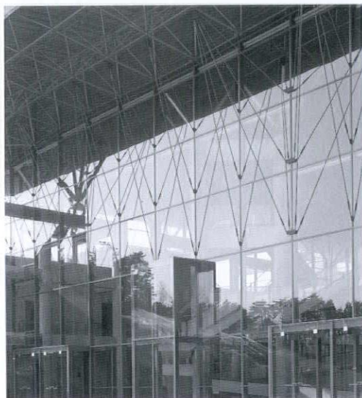
〈ふるさとバレス ギャラクシー富山〉(1992) 10mの高さに対して通常のマリオンの見込みを1/4以下にするテンションロッド。床面での視野は開放される。
