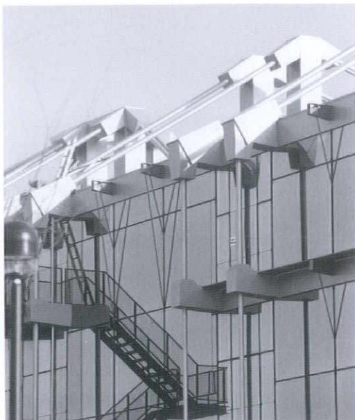
〈西部ガスミュージアム 自然現象美術館〉(1989) カーテンウォール。マリオン上の変形の大きい中心を内外で拘束する。
